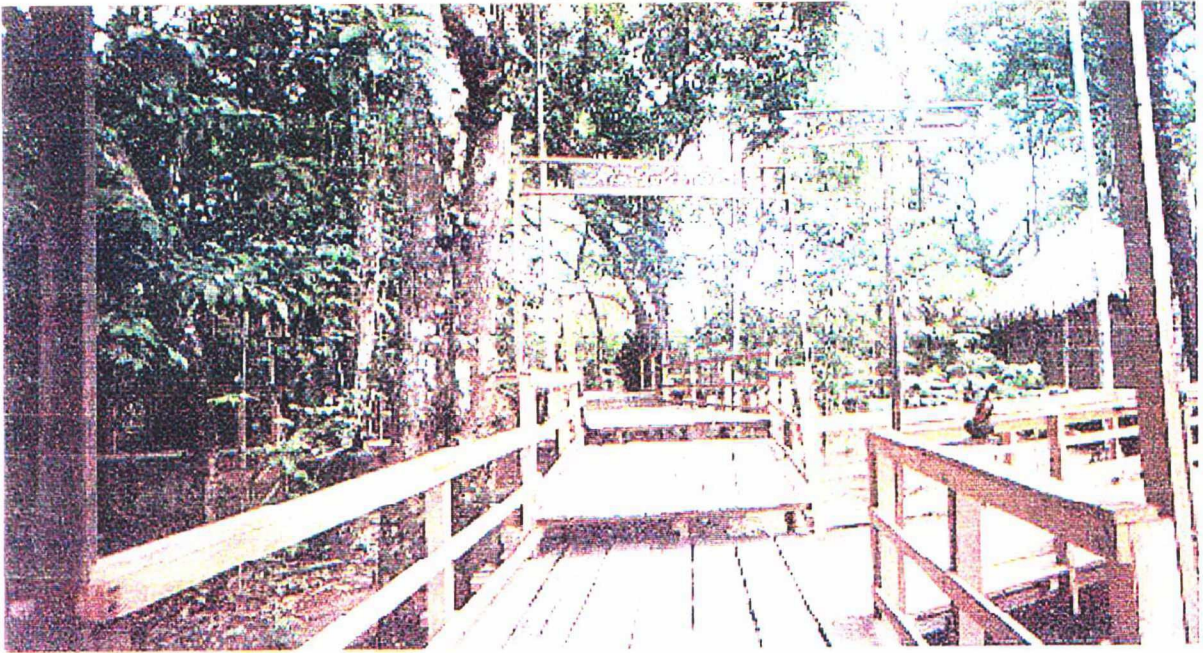
Passarela de acesso às cabanas Fonte: Hotel Acajatuba
