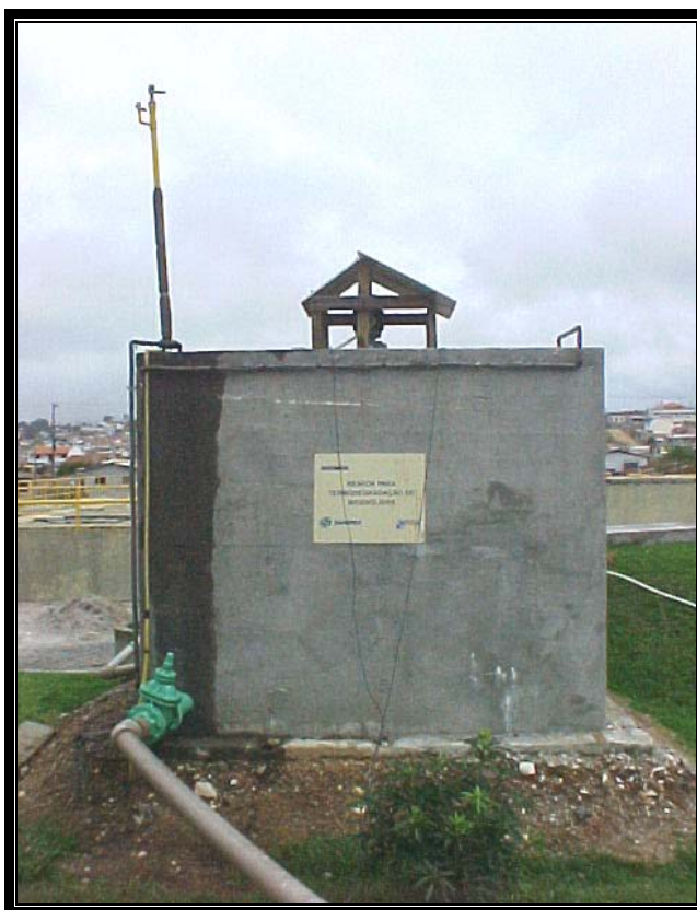
FIGURA 11 - TERMOHIDROLISADOR FEITO EM ESTRUTURA DE CONCRETO
