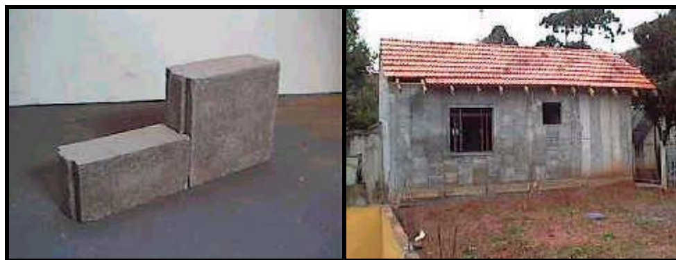
FIGURA 2.22 – Blocos de ISOPET intertravados e Protótipo “Unidade Conhecimento”. (FONTE: ANBIO, 2001))
