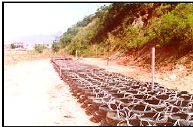
FIGURA 2.7 – Estágio intermediário e detalhe da amarração com corda de polipropileno. (FONTE: MEDEIROS et al., 1997)
