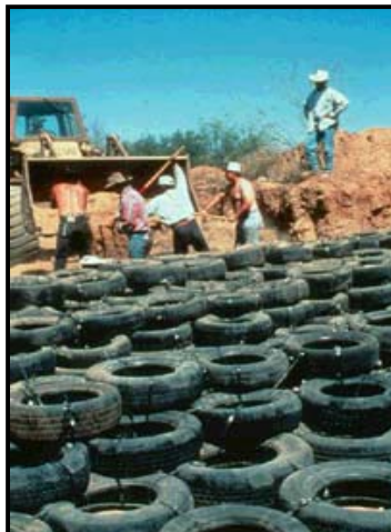
FIGURA 2.10 – Construção de uma barreira com pneus inservíveis. (FONTE: Goodyear, 1996)
