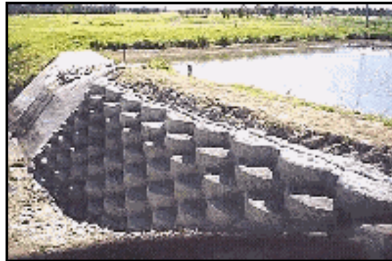
FIGURA 2.9 – Parede de ECOFLEX TM em bacia de retenção, Hexham, Australia. (FONTE: JAYAWICKRAMA, P.W. et. al., 2000)
