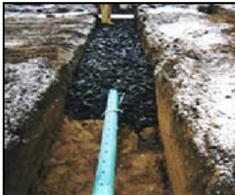
FIGURA 2.17 – Sistema séptico de drenagem. (FONTE: www.4entech.com/Rubber_Rock/rubber_rock.html )
