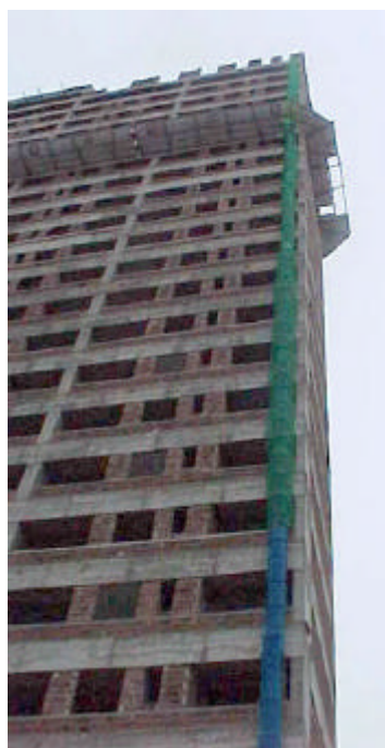
Condutor de entulho
