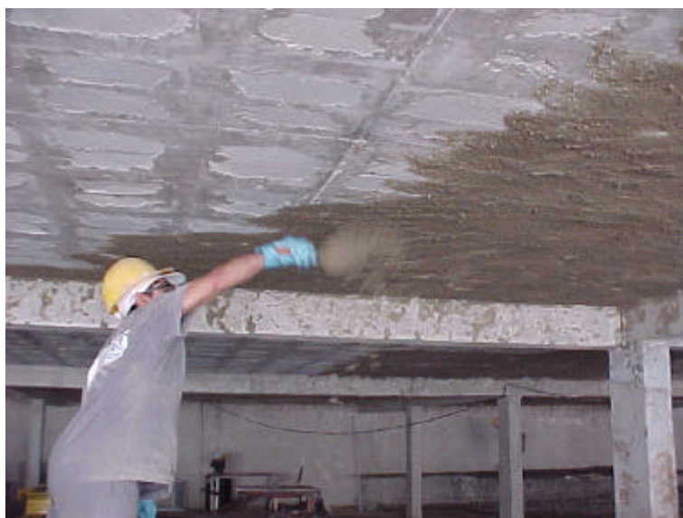
Chapisco de teto
