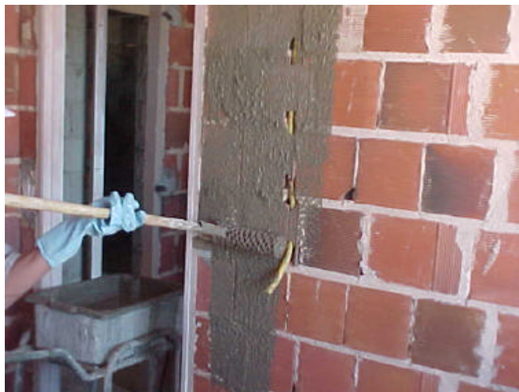
Chapisco de parede
