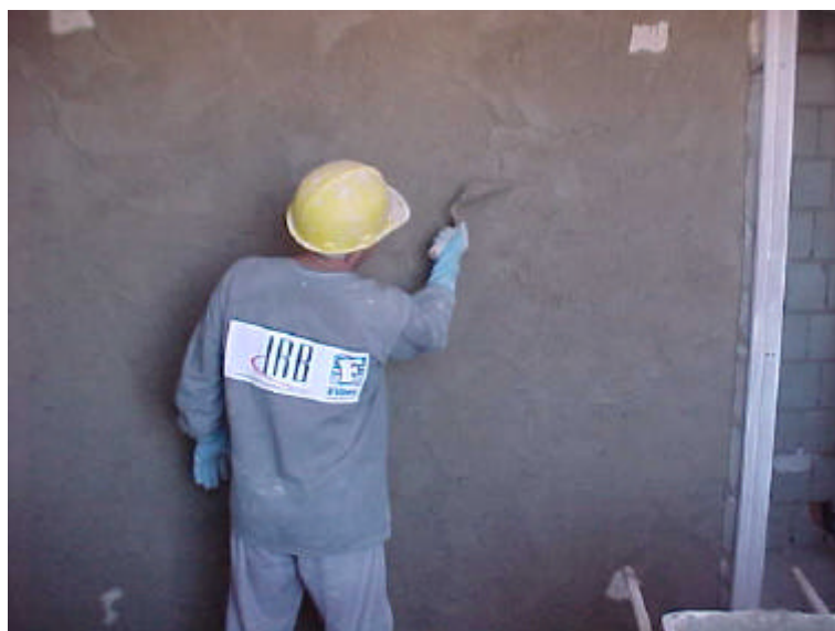
Reboco de teto
