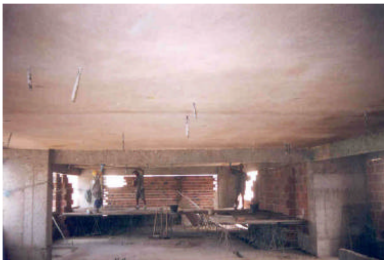
Reboco de teto
