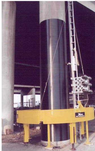
Figura 1.1 – Aplicação automática da fibra de carbono em pilar de concreto, XXsys Technologies, Inc. (2000)
