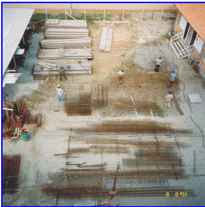
FIGURA 6.2: Lay-out dos armadores antes do 5S
