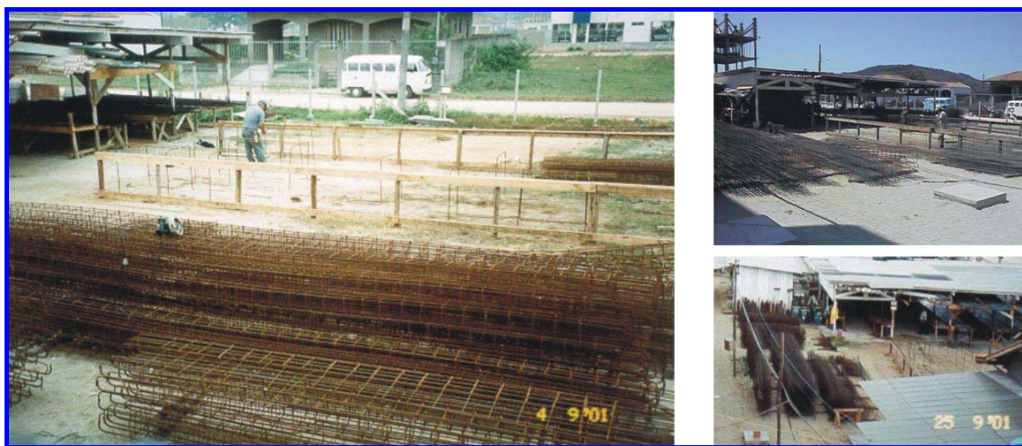
FIGURA 6.3: Lay-out de canteiro de obras após a implantação do 5S.
