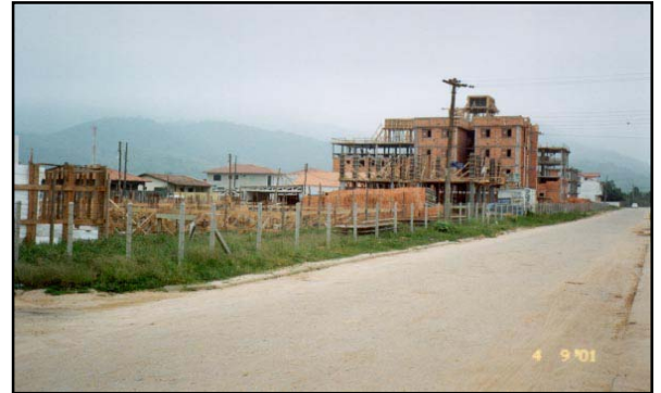
18- Vista para o bloco "B"
