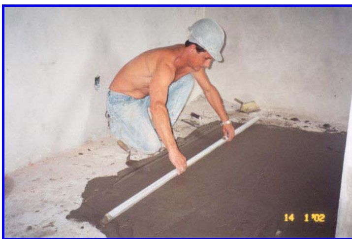
FIGURA 5.26: Regularização da laje para o assentamento do piso
