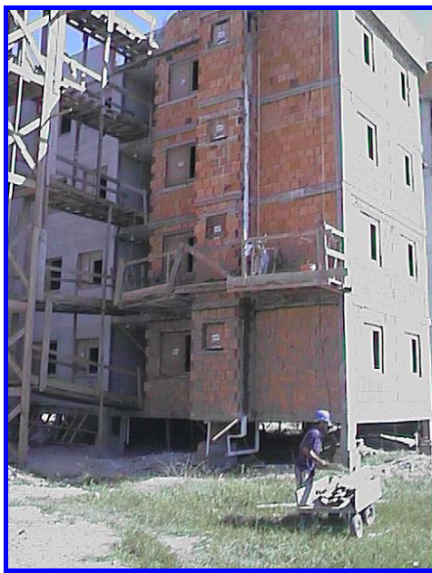
FIGURA 5.22: Dificuldade de executar o reboco externo com passarela de acesso ao elevador de cargas
