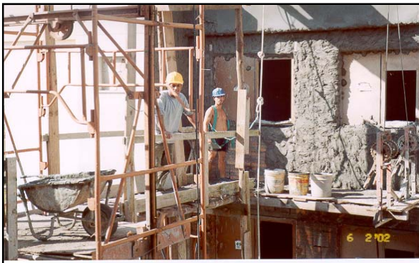
11- Reboco externo sendo abastecido pelo elevador, bloco "H"
