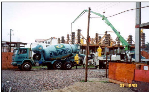
3- Concretagem dos pilares do bloco "I"
