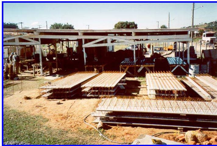
FIGURA 5.5: Pátio de execução das treliças e armazenamento antes da implantação do 5S
