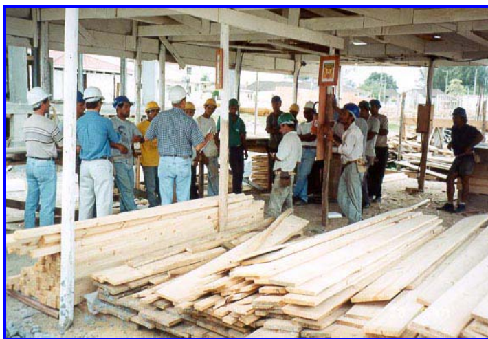
FIGURA 6.8: Treinamento com as equipes de armadores e carpinteiros
