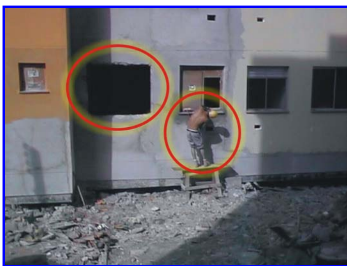
FIGURA 5.29: Retoques em paredes prestes a receber pintura
