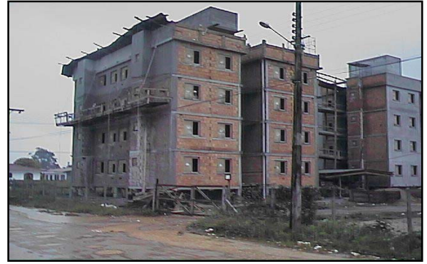
10- Bloco "H" reboco externo com proteção de chuva, na data de 05/12/2001
