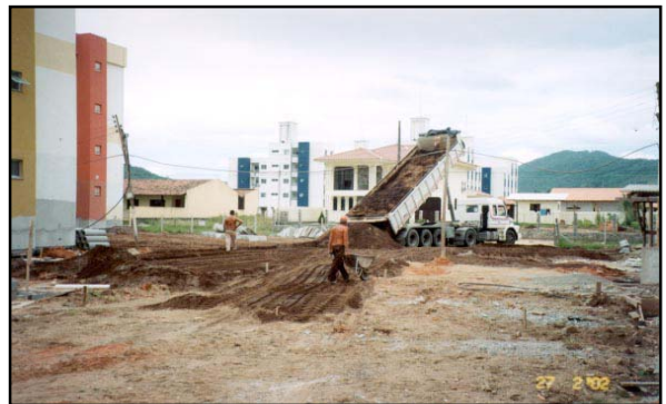
14- Execução do aterro, dos pátio dos blocos "FGIH"
