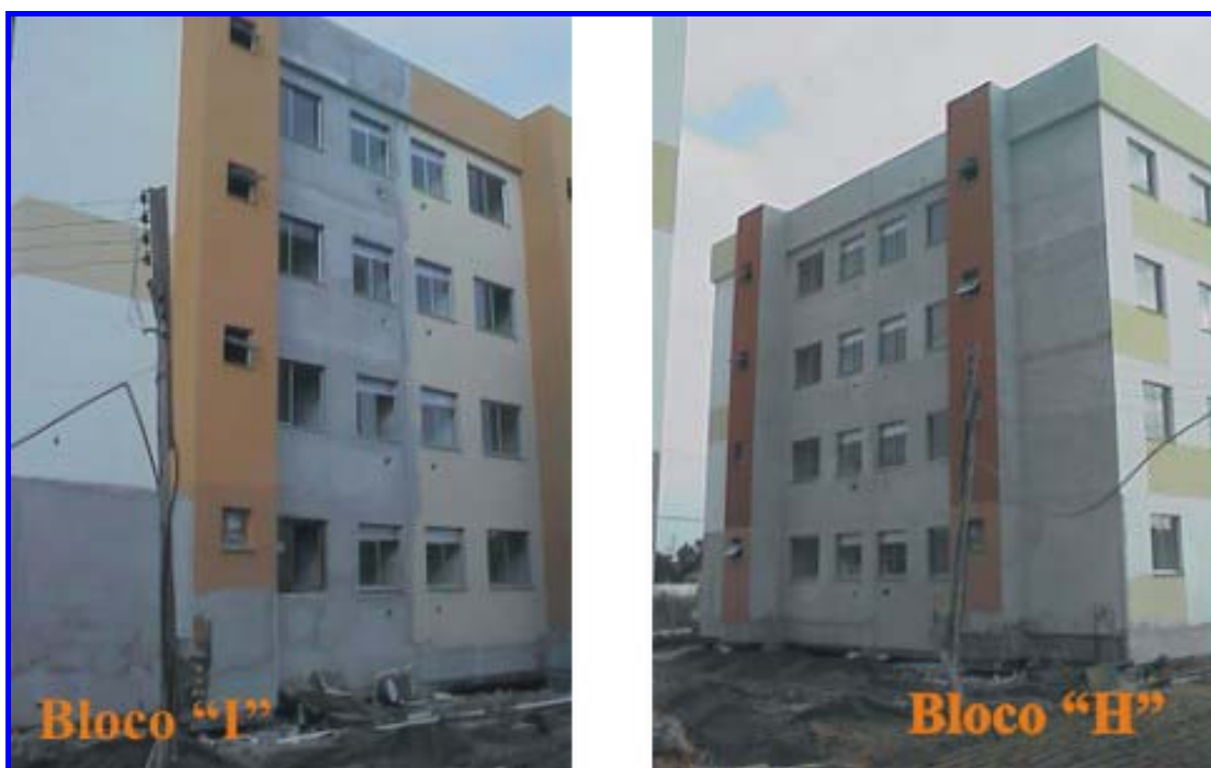
FIGURA 5.30: Paralisação na pintura das fachadas dos blocos
