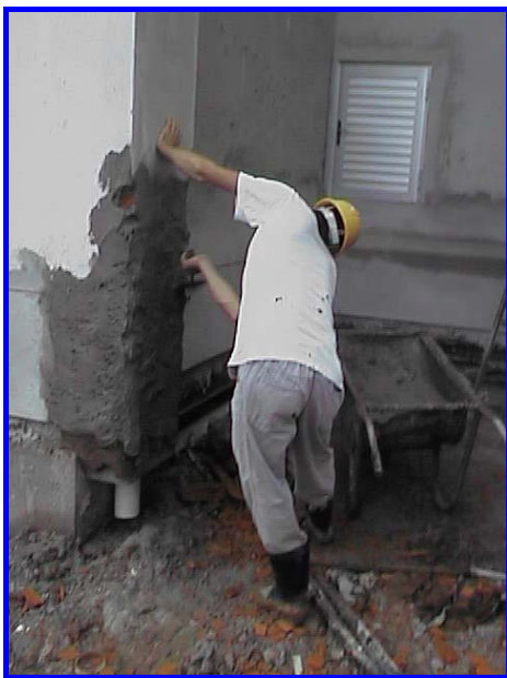
FIGURA 5.20: Execução do reboco nas muchetas (bonecas)
