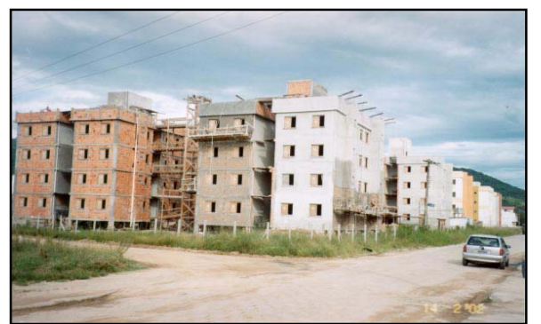
20- Vista para o bloco "B"
