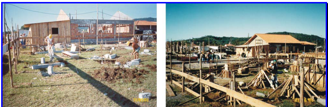
FIGURA 5.7: Atividade de fundação
