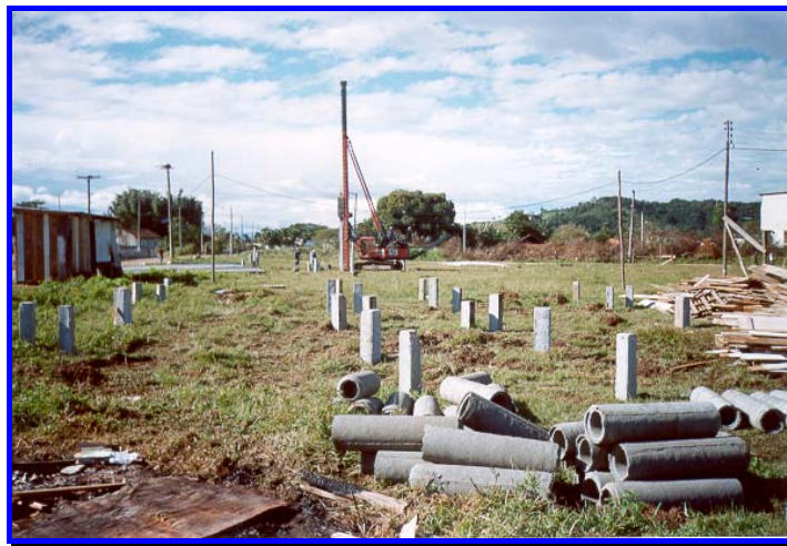
FIGURA 5.6: Cravação de estacas pré-moldadas
