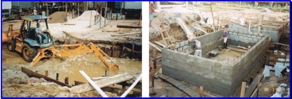
FIGURA 5.4: Executando a fossa-filtro entre os blocos “G” e “I”
