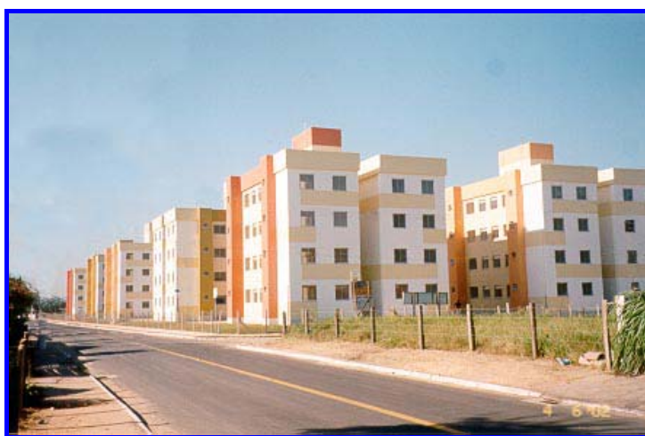
FIGURA 5.31: Empreendimento sendo finalizado
