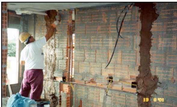
7- Chumbação da tubulação, parede da cozinha
