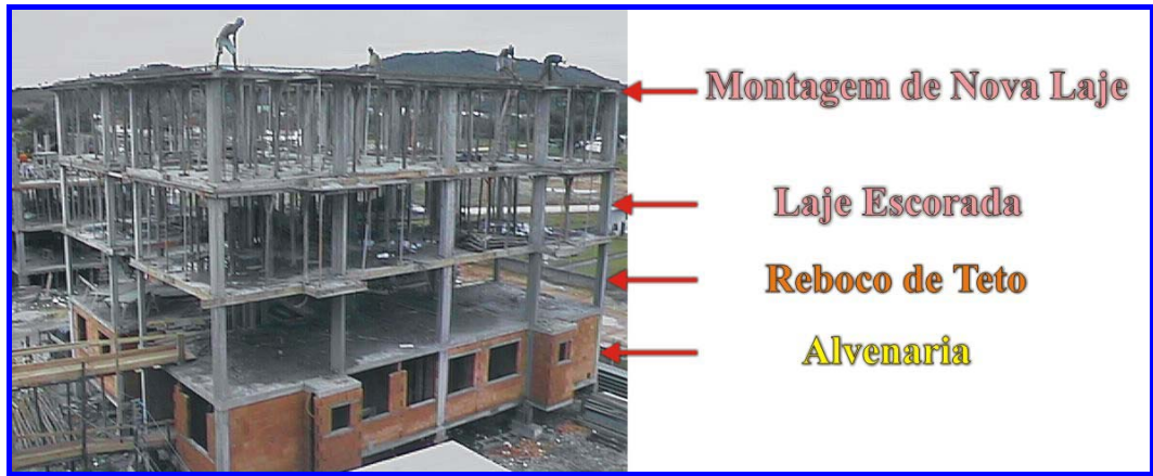
FIGURA 5.2: Seqüenciamento das atividades de estrutura, reboco de teto e alvenaria no bloco “C”.
