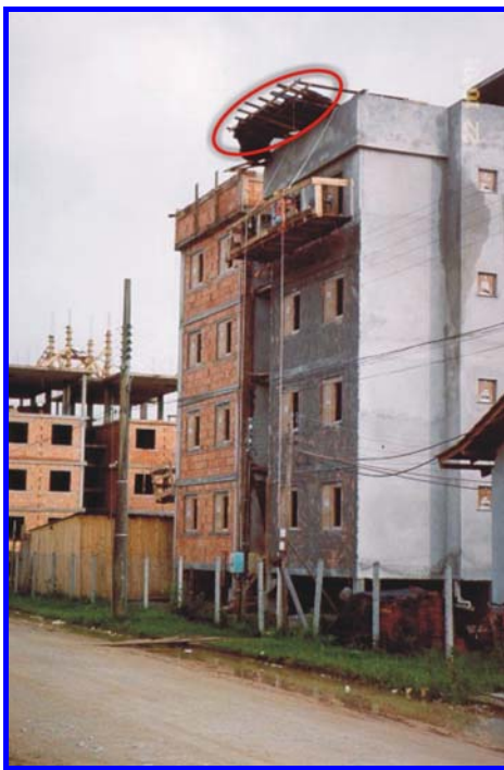
FIGURA 5.18: Proteção contra chuva no jaú do reboco externo
