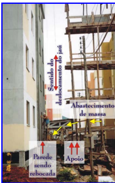
FIGURA 5.19: Corte na passarela para passar o jaú.
