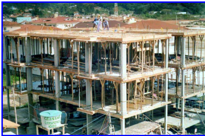
FIGURA 5.10: Montagem da laje bloco “F”
