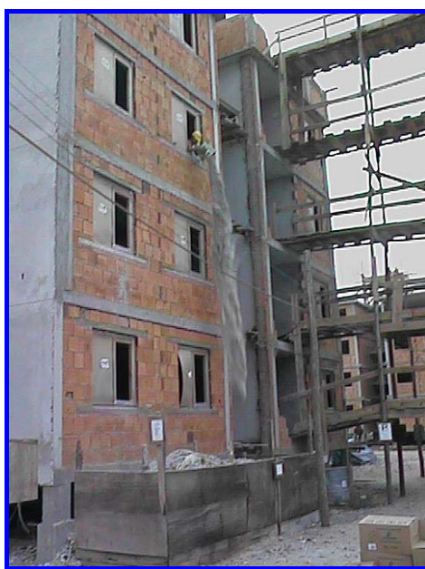
FIGURA 6.22: Utilização da caixa de entulho bloco “D”
