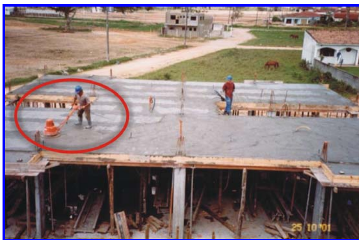
FIGURA 5.25: Nivelamento da laje para contra-piso zero
