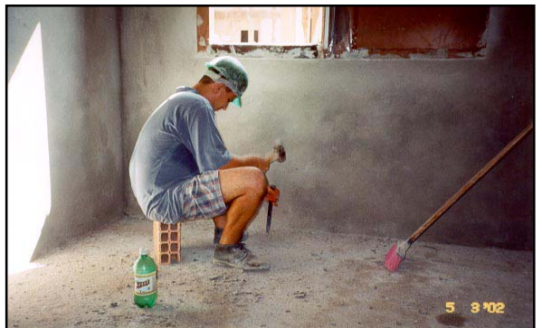
12- Preparação da laje para regularização
