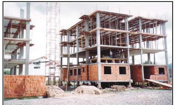
6- Laje térreo: equipe de alvenaria Laje 01: equipe de reboco de teto Laje 02 e 03: laje escorada Laje cobertura: concretada em 19/09/01
