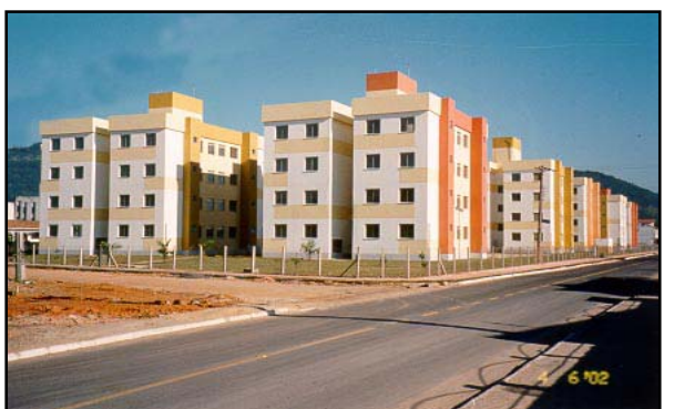
22- Vista para o bloco "B"
