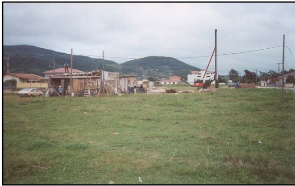
1- Início da obra: 15/05/2001
