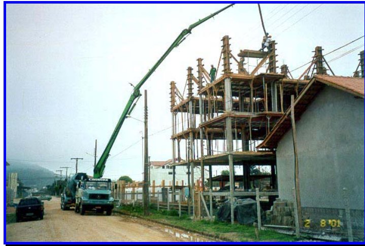
FIGURA 5.9: Concretagem dos pilares do bloco “F”
