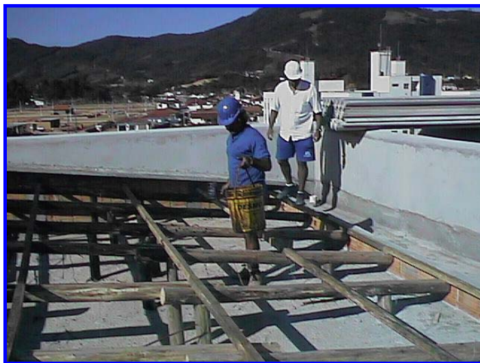
FIGURA 5.28: Estrutura de madeira do telhado sendo pintado com óleo.
