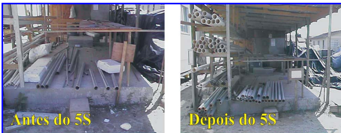
FIGURA 6.16: Ambiente de trabalho do encanador e do eletricista antes e depois da implantação do 5s
