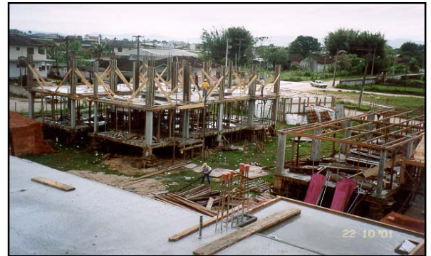
2- Equipe de estrutura no bloco "B" e "A"
