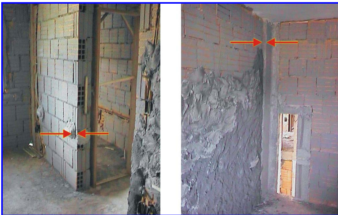
FIGURA 5.17: Camada de enchimento de argamassa, para posteriormente executar o reboco
