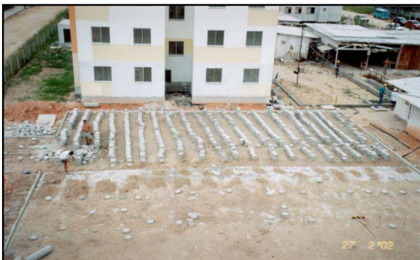
15- Assentamento de bloco de concreto do estacionamento dos blocos "EFG"
