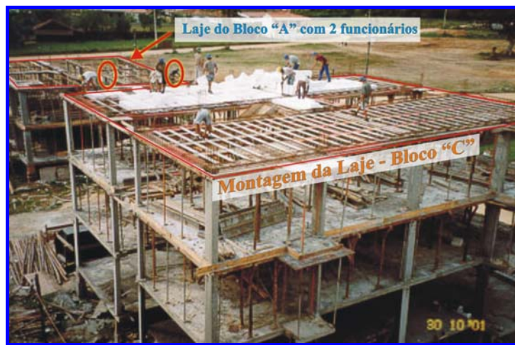
FIGURA 5.11: Montagem da laje do bloco “C”
