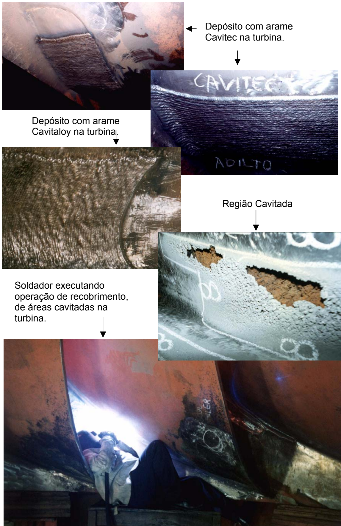
Fig. 4.26) – Fotos de partes da turbina soldadas com o pulsado com pulsação térmica.
