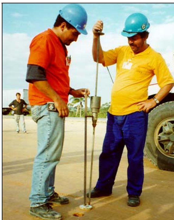
FIGURA 2.2 - Ensaio do Penetrômetro Dinâmico de Cone (DCP) em campo.
