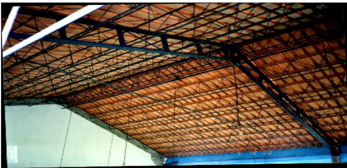
Figura 14: Visão Interna do Telhado (1)
