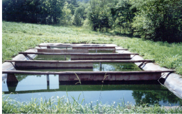
Figura 3.4. Lagoa facultativa com chicanas do sistema real.
