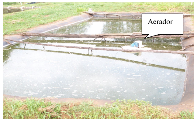
Figura 3.5. Lagoa facultativa aerada do sistema real.
