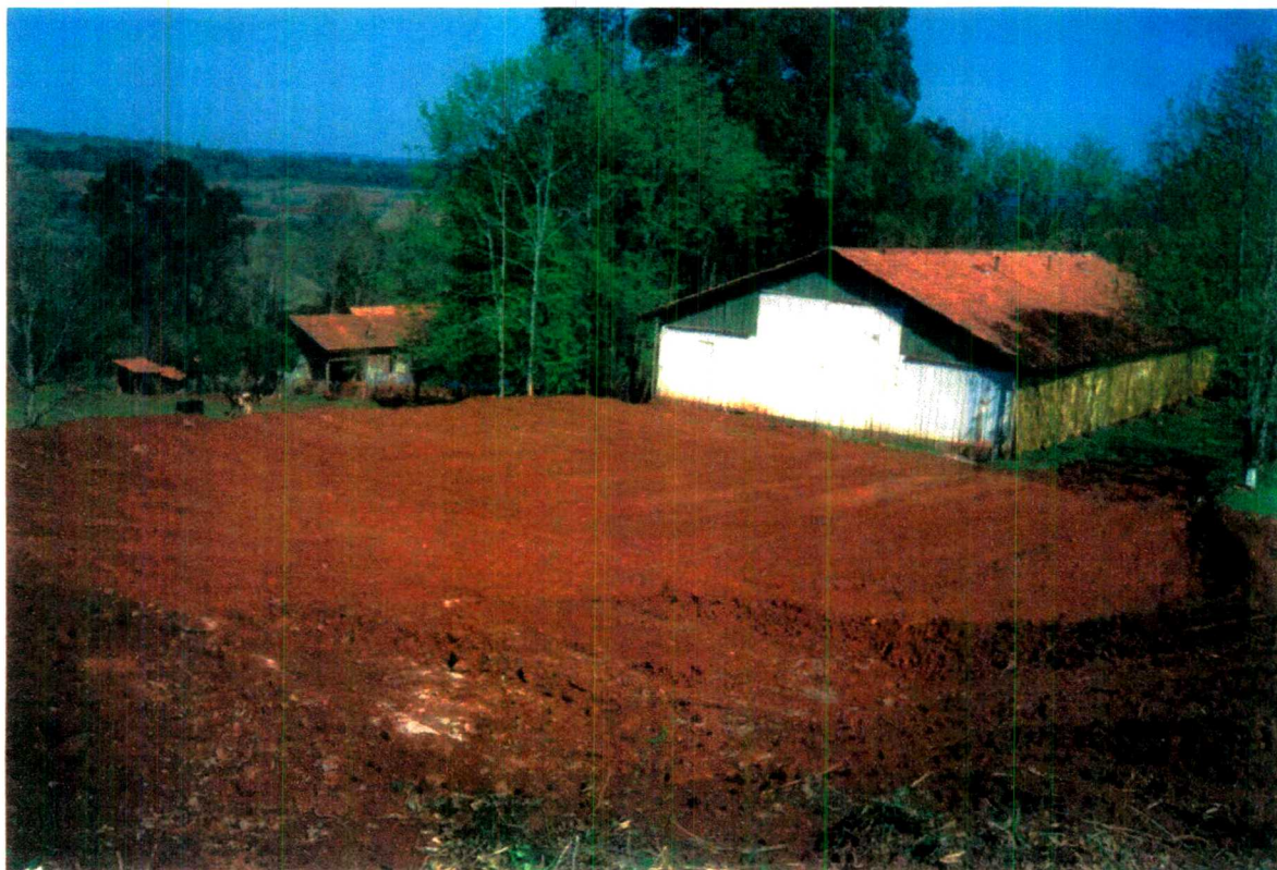
Terraplanagem para ampliação de aviário Foto: arquivo SMAT
