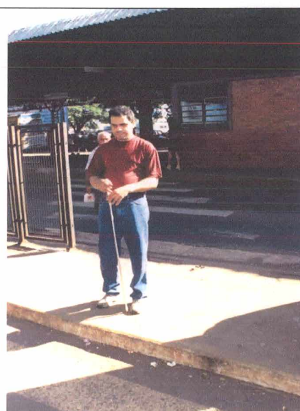
Figura 140: Travessia perigosa, ausência de sinalização.
