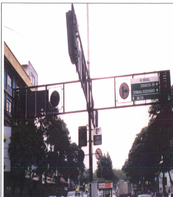
Figura 91: Placas de sinalização instaladas na estrutura das sinaleiras.
