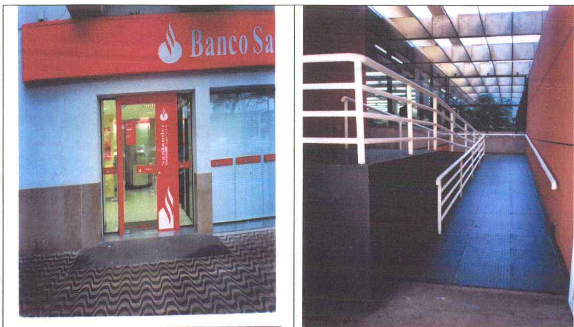
Figuras 155 e 156 : Acesso facilitado por rampas.
