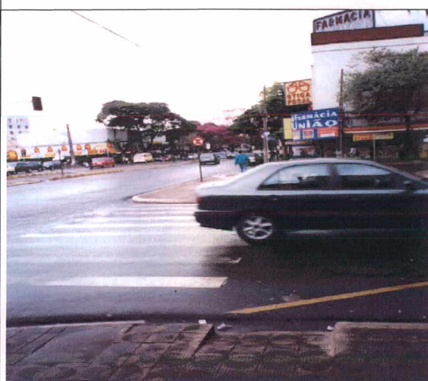
Figura 52: Rebaixo deslocado da faixa de travessia
