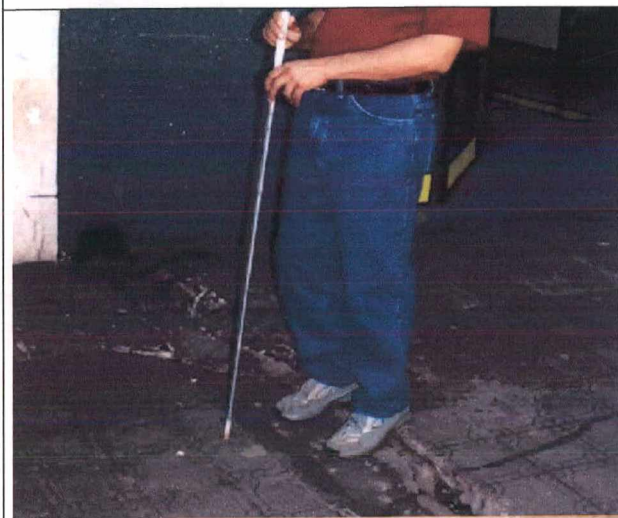
Figura 12: Desnível de piso no passeio
