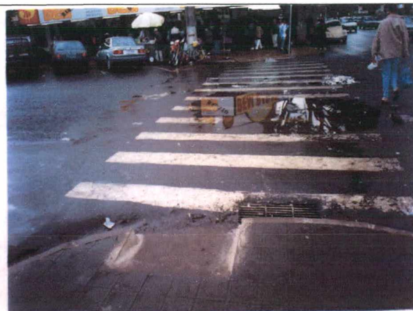
Figura 50: Rebaixo de guia e faixa de travessia
