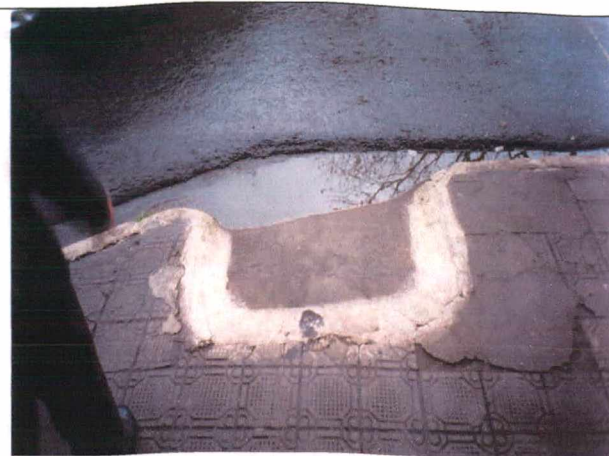
Figura 49: Rebaixo de guia, sarjeta.
