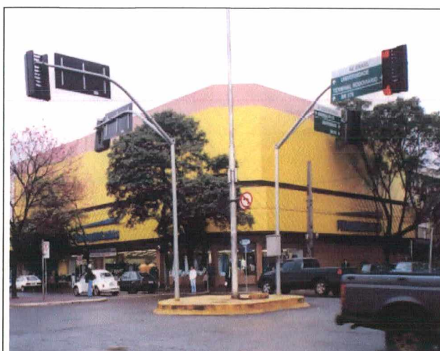
Figura 97: Sinaleira para trânsito de veículos, Avenida Brasil x Avenida D. Caxias.
