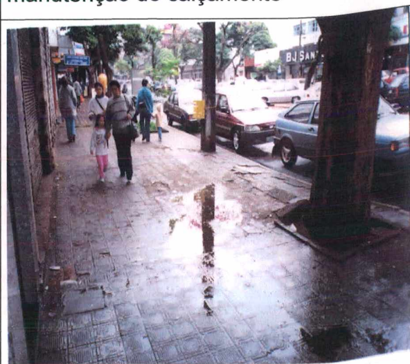
Figura 13: Falta de manutenção, acúmulo de água
