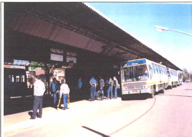
Figura 127: Vista do terminal, ônibus T.C.C, Maringá.
