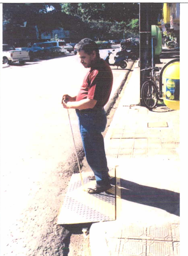
Figura 35: Rampa existente confeccionada em chapa metálica.
