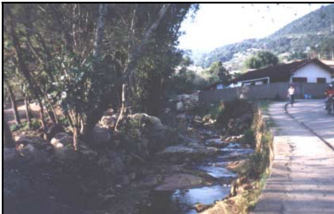
Figura 20 - Ocupações urbanas e rodovias pavimentadas construídas sobre as margens da drenagem que desce o morro do Quilombo, localizadas na porção norte da área de pesquisa, no bairro Itacorubi (outubro/2002).
