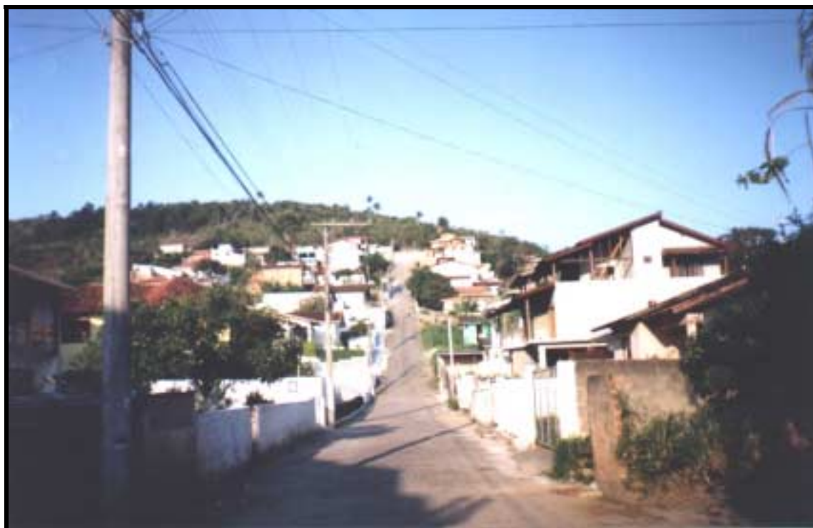
Figura 21 - Avanço da ocupação urbana em direção as médias e altas encostas no setor norte da área de pesquisa, bairro Itacorubi (outubro/2001).
