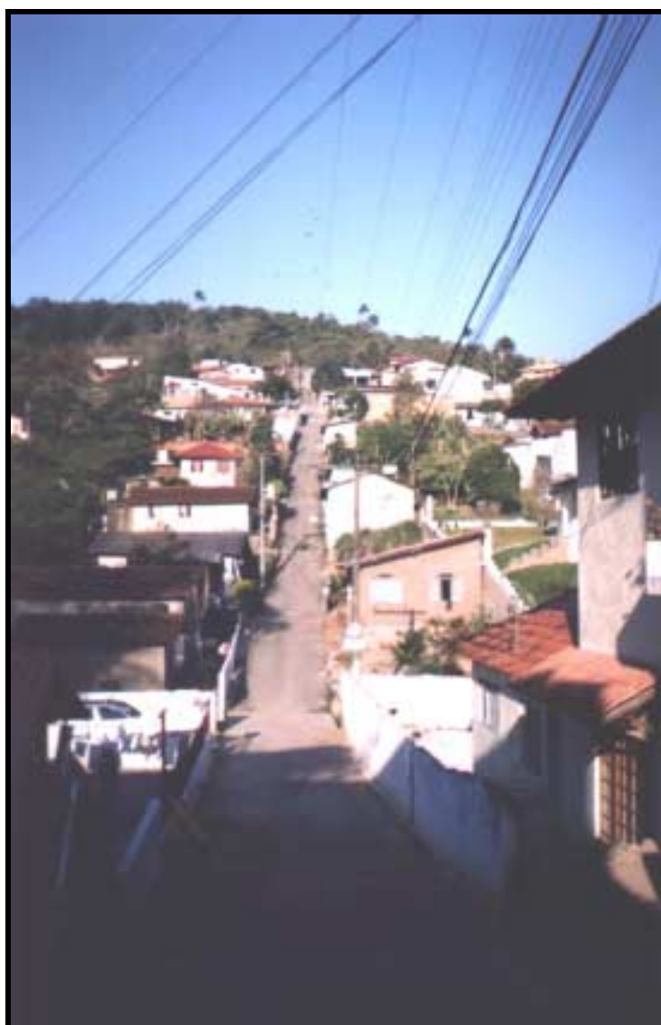
Figura 14 - Ocupação urbana avançando na direção das altas encostas, no setor norte da área de pesquisa, onde a declividade fica acima de 30% (outubro/2001).
