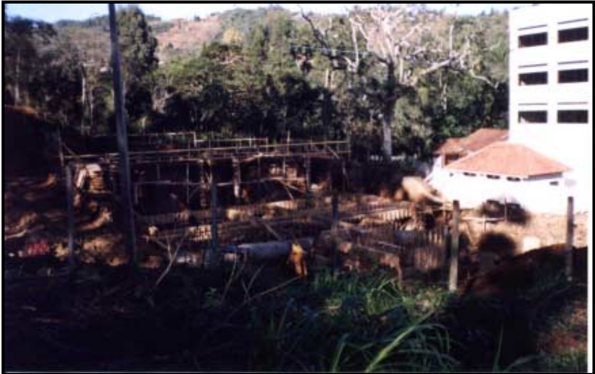
Figura 10 – Evidência da construção de edificações urbanas sobre o curso d'água no local identificado como Depósito de Colúvio, com deterioração da vegetação natural e a canalização da drenagem (julho/2001).
