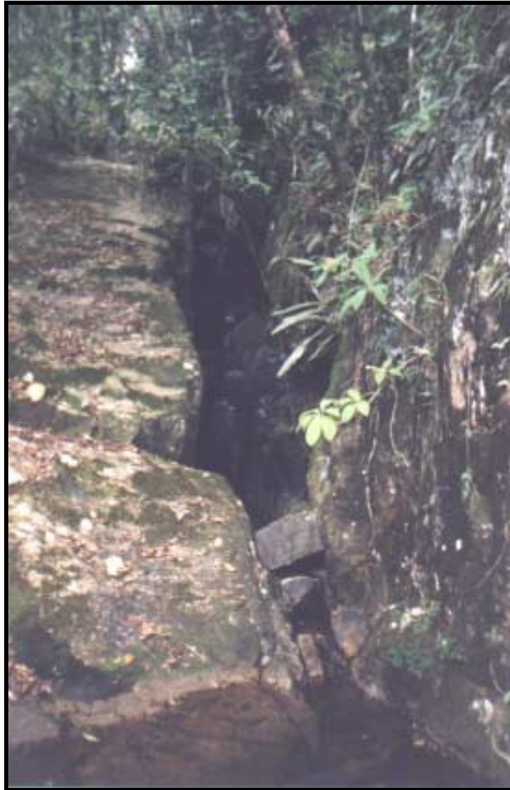
Figura 12 – Destacando o controle morfoestrutural da drenagem feito por uma falha no terreno, setor sudoeste da área de estudo, num curso d'água do Córrego Grande (julho/2001).
