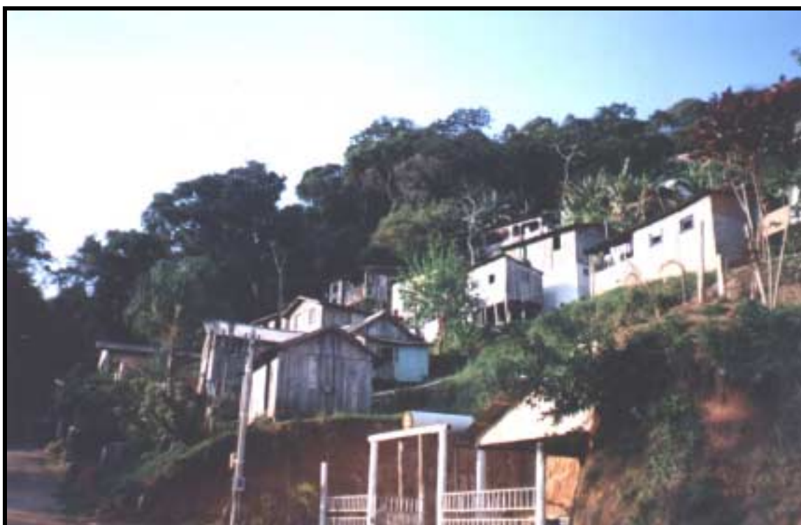
Figura 25 – Avanço da urbanização sobre as encostas no Morro do Quilombo, causando aumento da susceptibilidade a deslizamento (outubro/2001).
