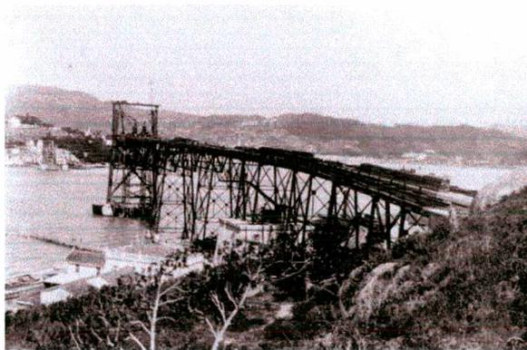
figura 47 – Montagem do viaduto, no Continente. **Fonte:** Banco de Imagens da Fundação Franklin Cascaes – FFC.
