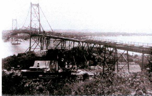
figura 49 – A ponte pronta para receber o soalho de madeira. Fonte: Banco de Imagens da Fundação Franklin Cascaes – FFC.
