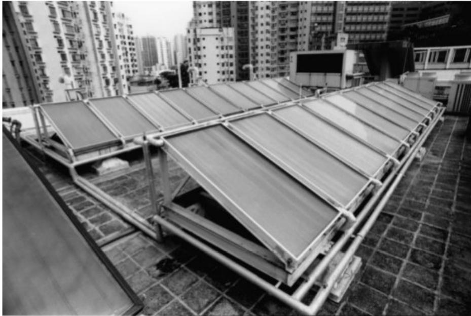
**Figura 1.3** Vista frontal do arranjo de coletores.
