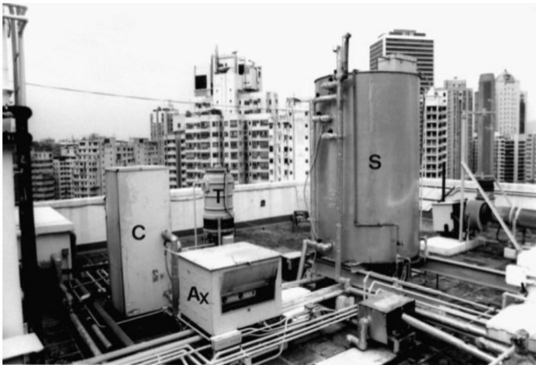
Figura 1.2 Componentes principais de um sistema de absorção.
