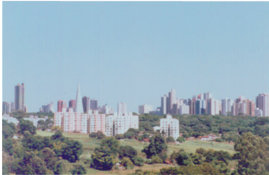
FOTO 13 - Observa-se no primeiro plano os Conjuntos Residenciais Vila Bella e Guaritá, distantes a apenas 2 km do centro da cidade, demonstrada ao fundo
