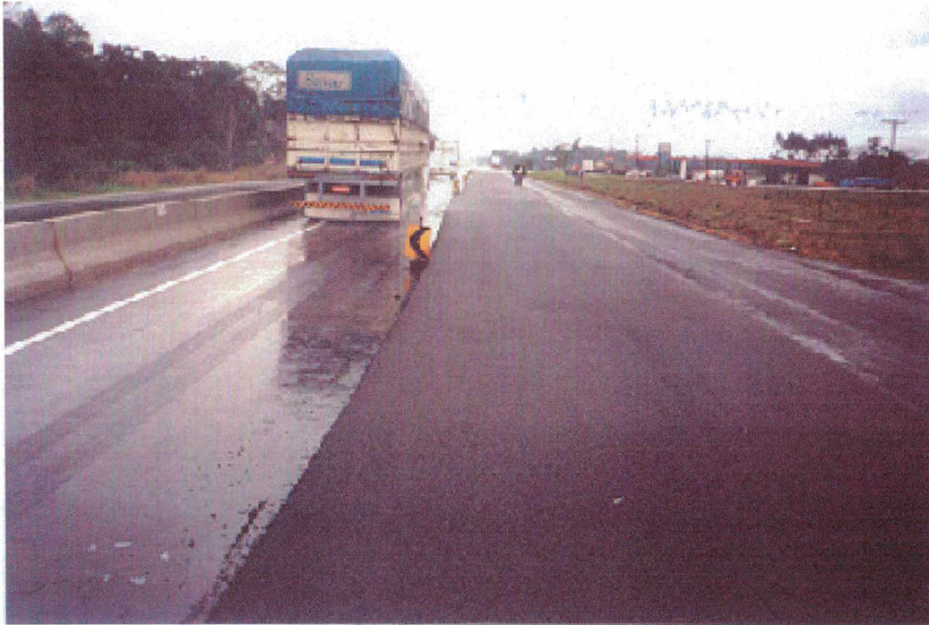
Figura 3.5: Trecho experimental com camada porosa de atrito no Km 10 – km11 da BR-101
