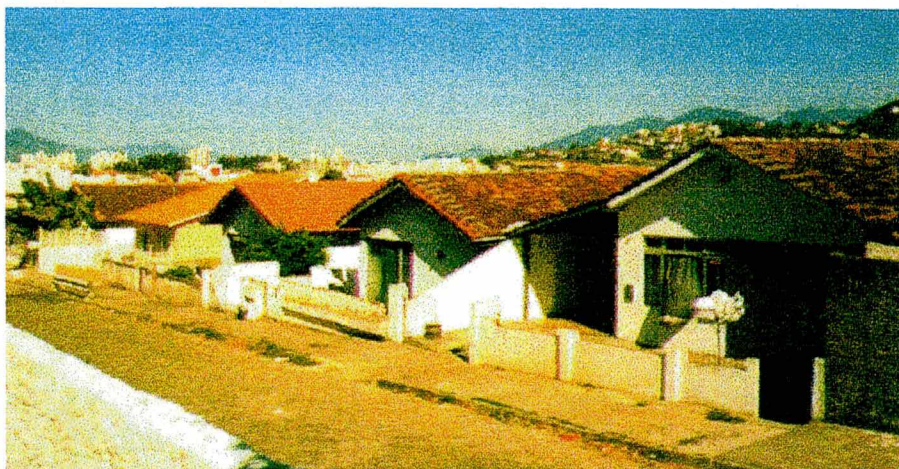
Foto II.5.2.2. Sequência de telhados das fachadas originais
