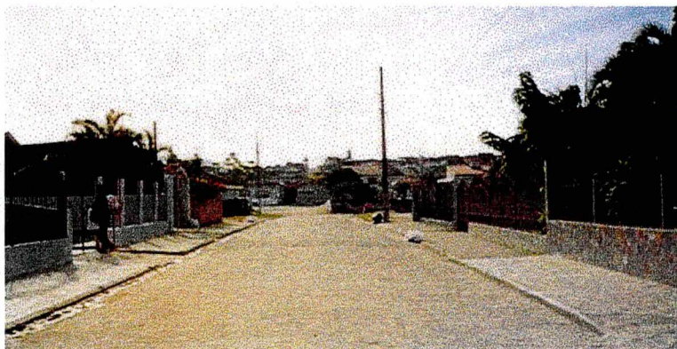
Foto II.6.12. Vista da Rua Salvador.
