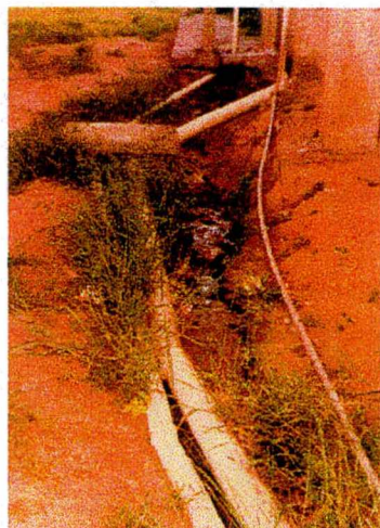
Foto II.5.1.3. Lote com esgoto a céu aberto
