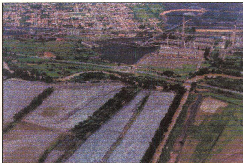
Vista Panorâmica da Usina Termelétrica Jorge Lacerda, Capivari de Baixo, Santa Catarina.
