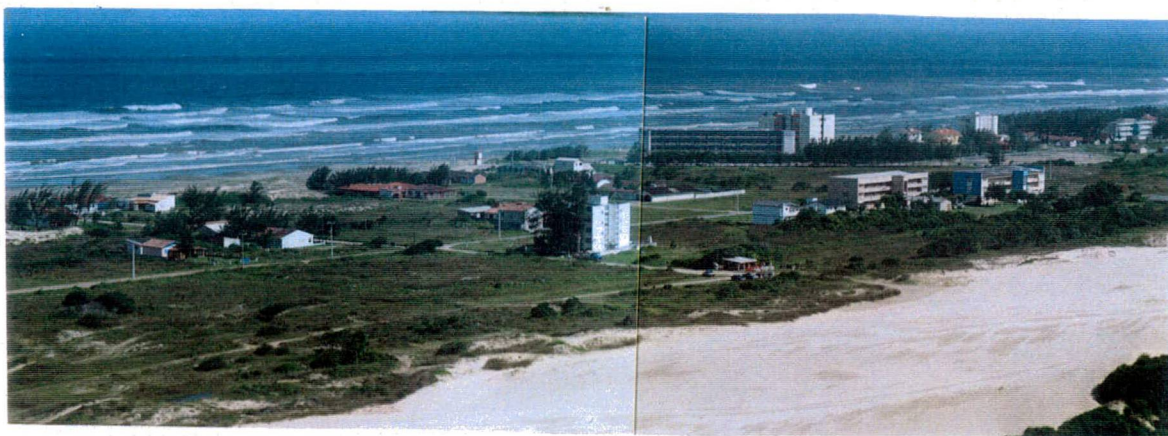
5. Ocupação em campo de dunas – Morro dos Conventos – Araranguá
