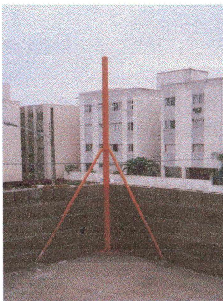
FOTO 04 – Escantilhão metálico
