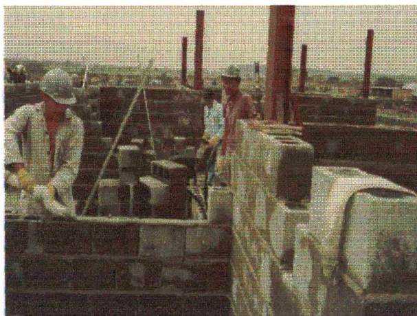
FOTO 08 – Bisnaga para assentamento de bloco.
