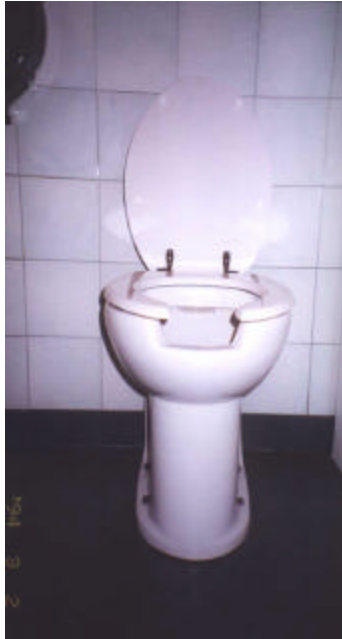
Figura 11: Vaso Sanitário de Banheiro Público – Itália
