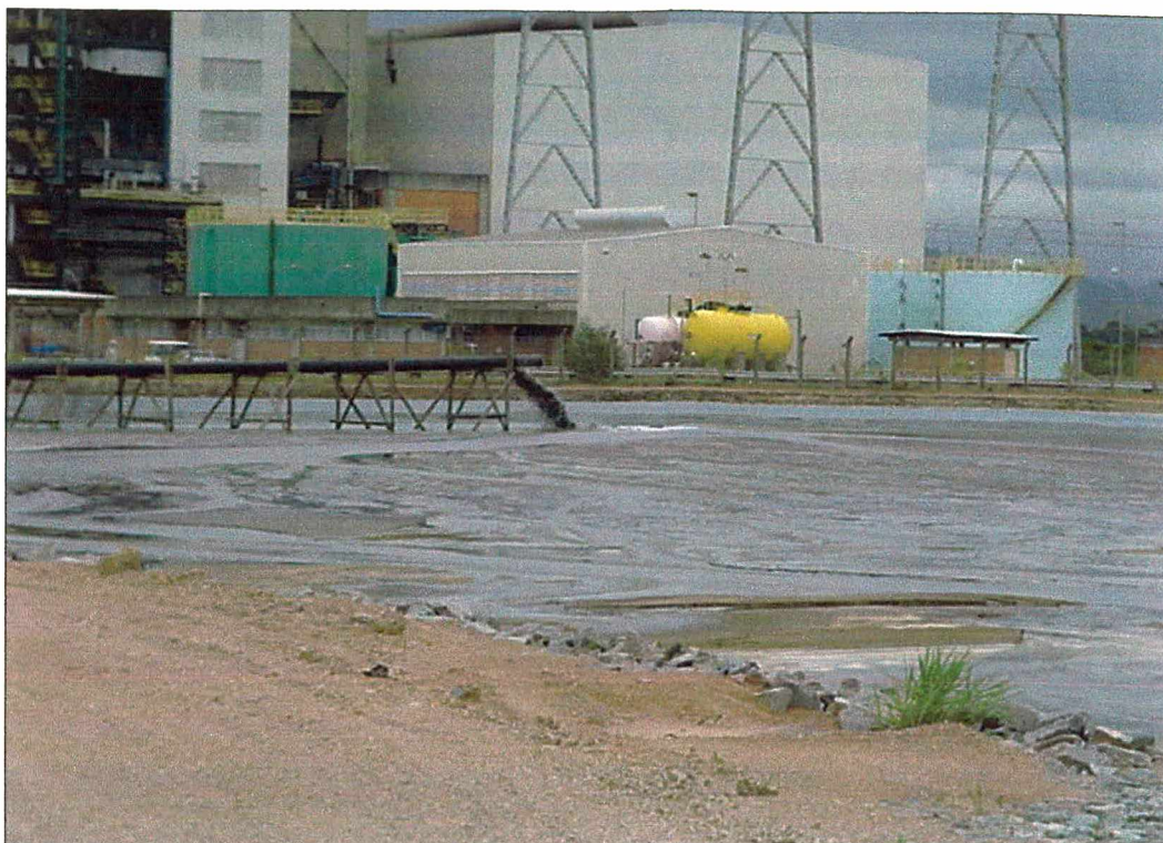
Figuras 3.1 - Descarte e depósito de cinzas pesadas em bacias de sedimentação.
