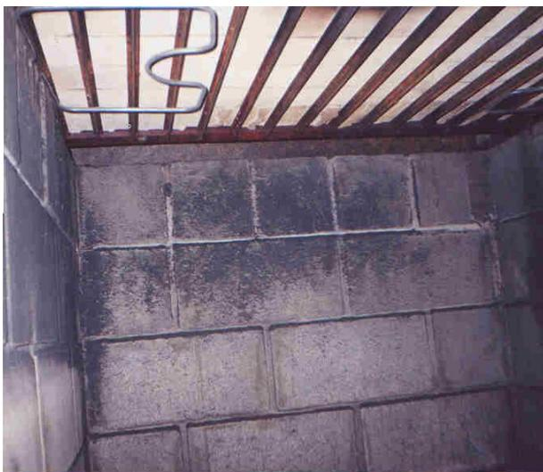
FIGURA 4.7: Depósito da cinza após sua segunda queima, destacando a localização das resistências blindadas.
