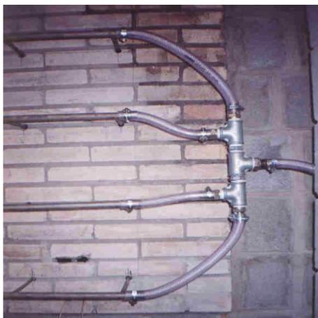
FIGURA 4.16: Chegada do ar comprimido às tubulações principais.
