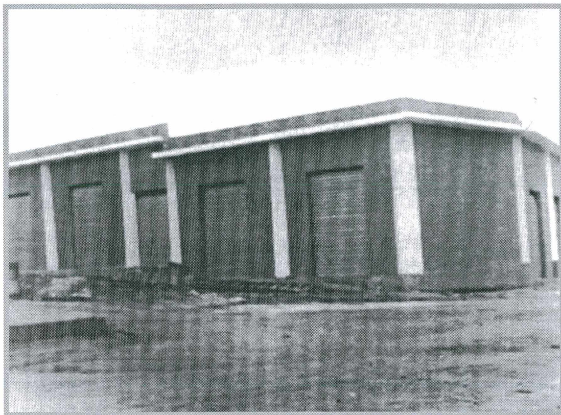
Fotografia 008. Antigo Mercado Municipal de São João da Ponte. Local onde atualmente funciona o Banco do Brasil.
