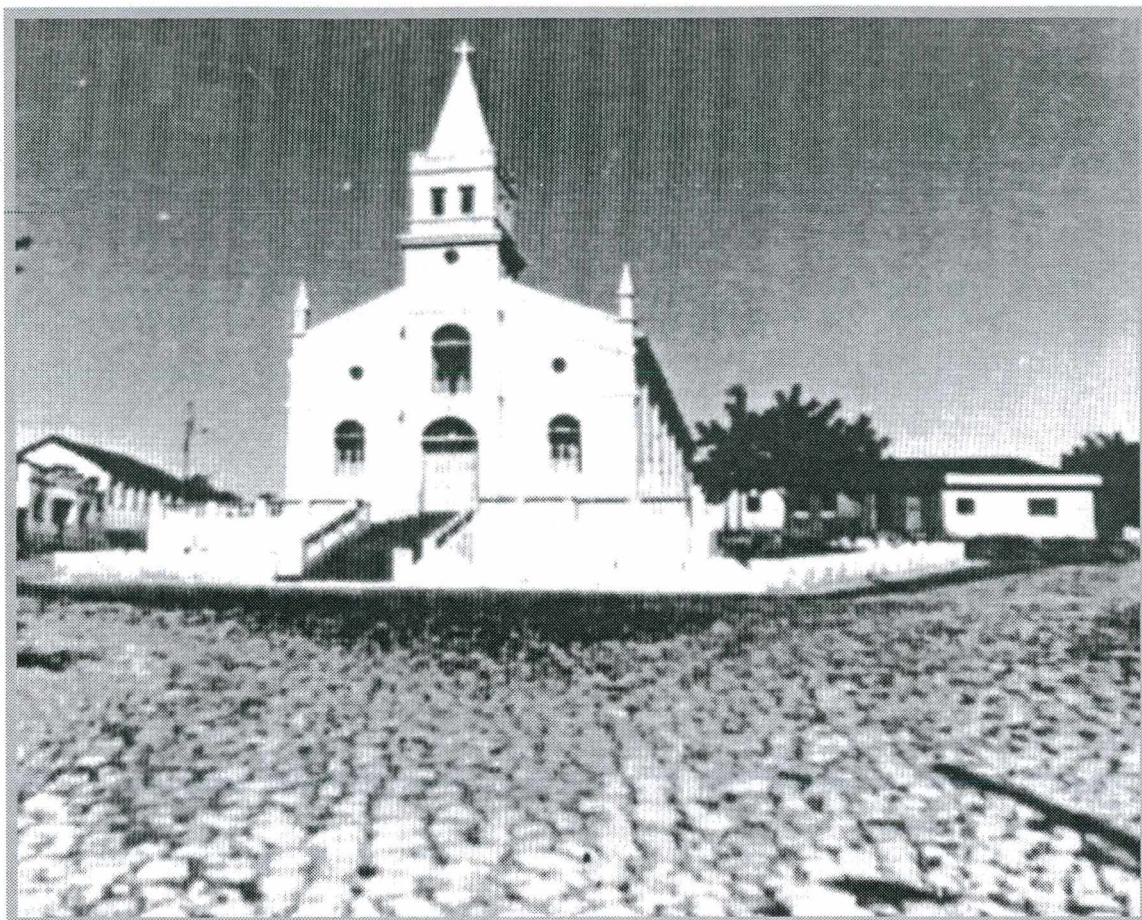
Fotografia 006. Igreja Matriz. São João da Ponte, 01 de fevereiro de 1973.
