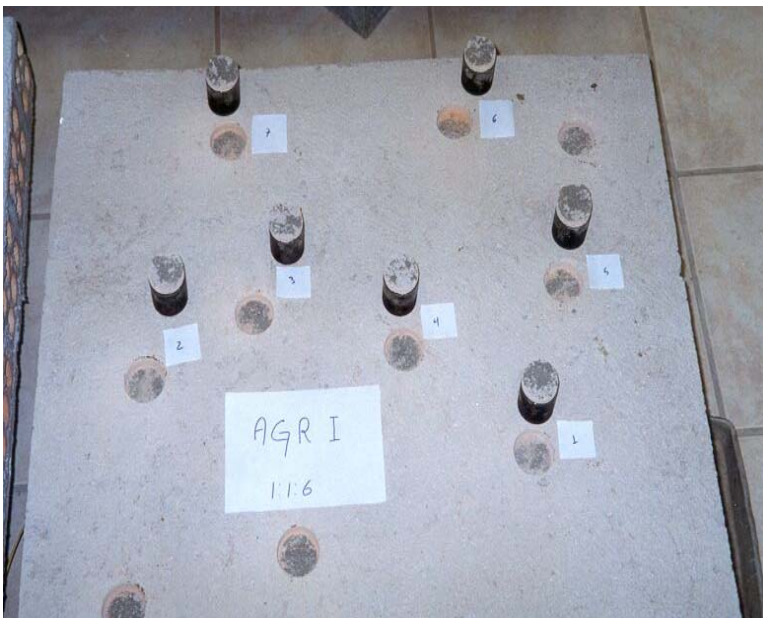
Figura 4.29 – Parede rebocada com AGR I – Traço 1:1:6
