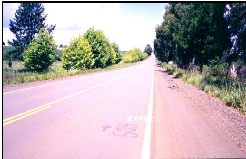
FIGURA 3.4 - Segmento S-09 (Km 84+000 da rodovia SC-302, trecho: Caçador - entroncamento com BR-116)
