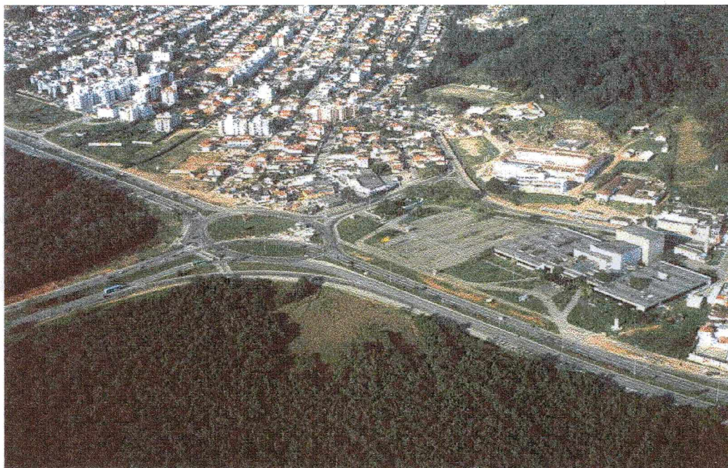
Figura 15 : CONSTRUÇÃO DO ELEVADO DO CIC NO BAIRRO TRINDADE EM 1998.
