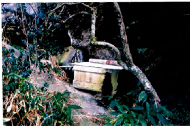
Fig. n.º 21 - Reservatório de água em cachoeira para abastecimento domiciliar.
