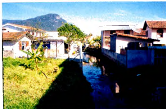
Figs. n.º 15, n.º 16 e n.º 17 – Ocupação das margens do Canal Sangradouro. Zona inundável. Encanamentos de água, lixo e entulhos sobre o leito do canal.
