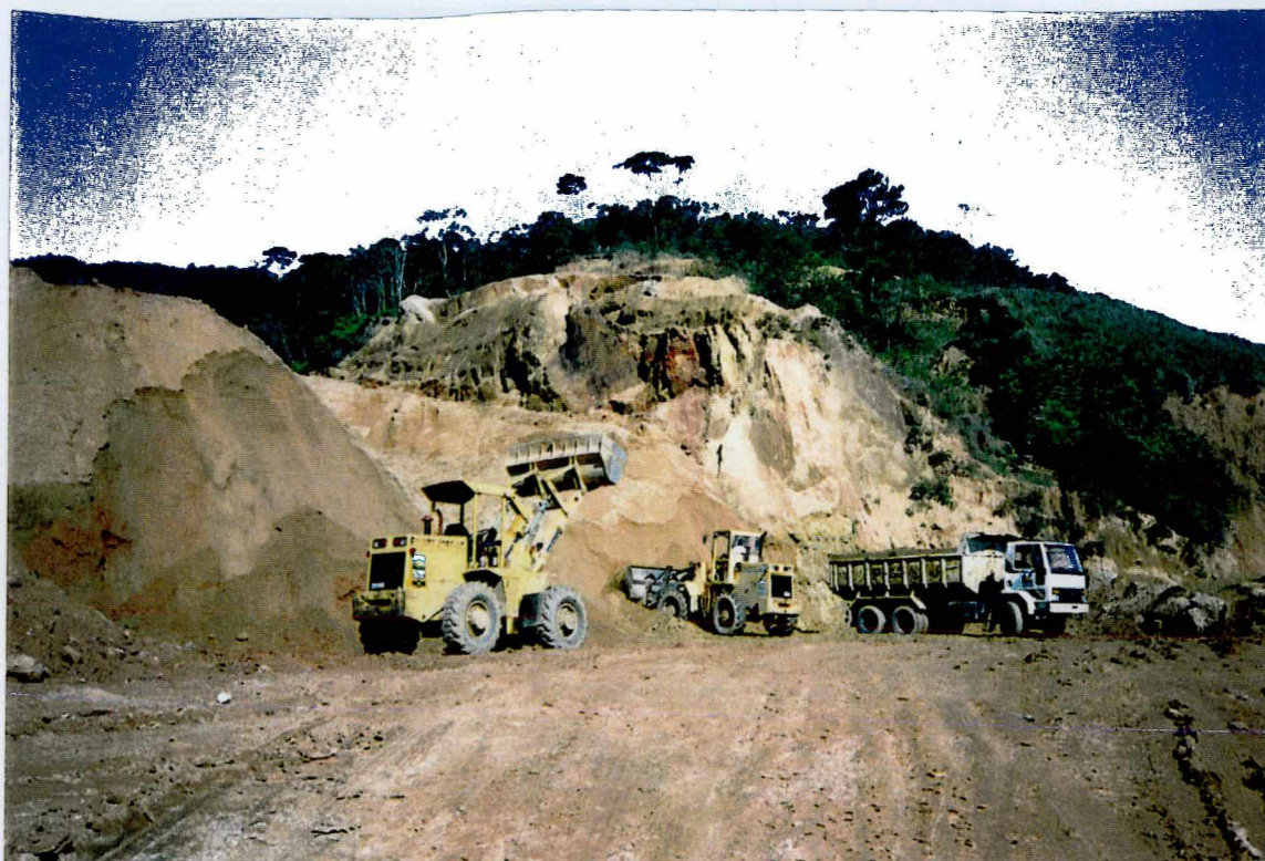
FOTO 6 - Em área próxima ao local, escavadeiras trabalham retirando terra para recobrimento dos resíduos sólidos situados no aterro
