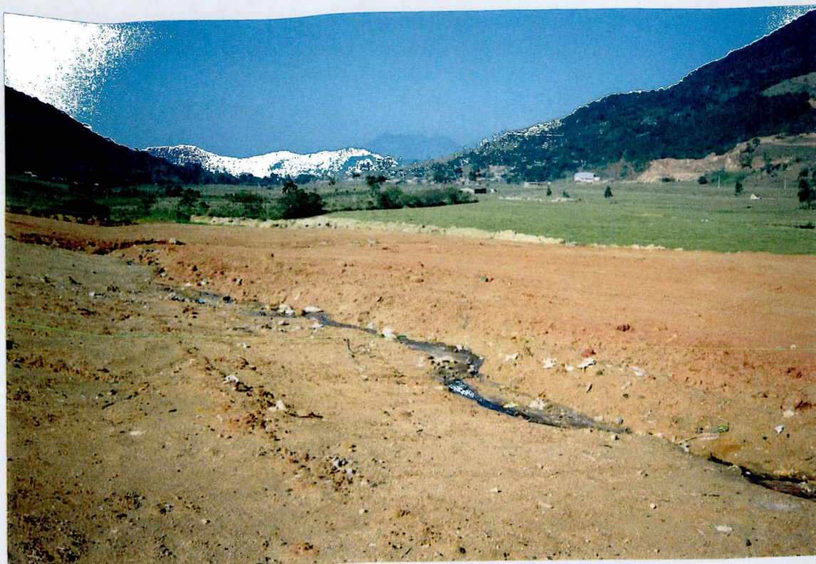
FOTO 5 - Após alguns dias de chuva, percebe-se a concentração de chorume na superfície do aterro
