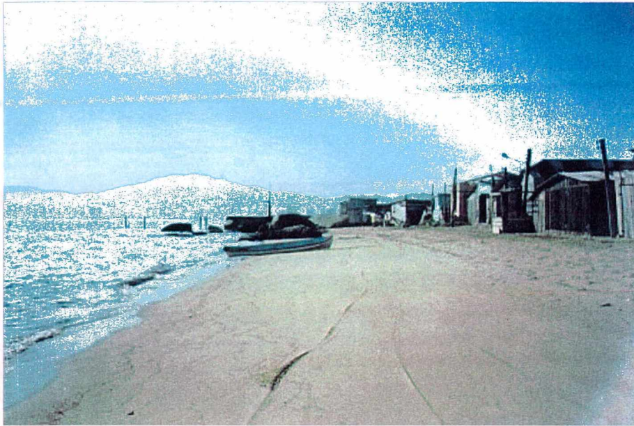
Figura 5.3 - Ponta do Leal, junto ao extravasor da CASAN. Esta visão está no sentido da Praia do Balneário, onde fica evidente a presença de construções irregulares na área considerada de proteção, faixa de marinha.
