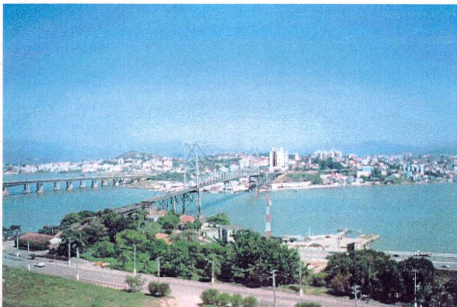
Figura 2.2 - Pontes que integram a Ilha ao Continente: vista parcial da Ponte Hercílio Luz, mostrando seu entorno, bem como a área continental ao fundo.
