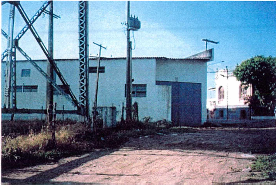
Figura 5.7 - Área da Empresa de Pescados Silveira que será desapropriada com a implantação da Avenida Beira Mar Continental.
