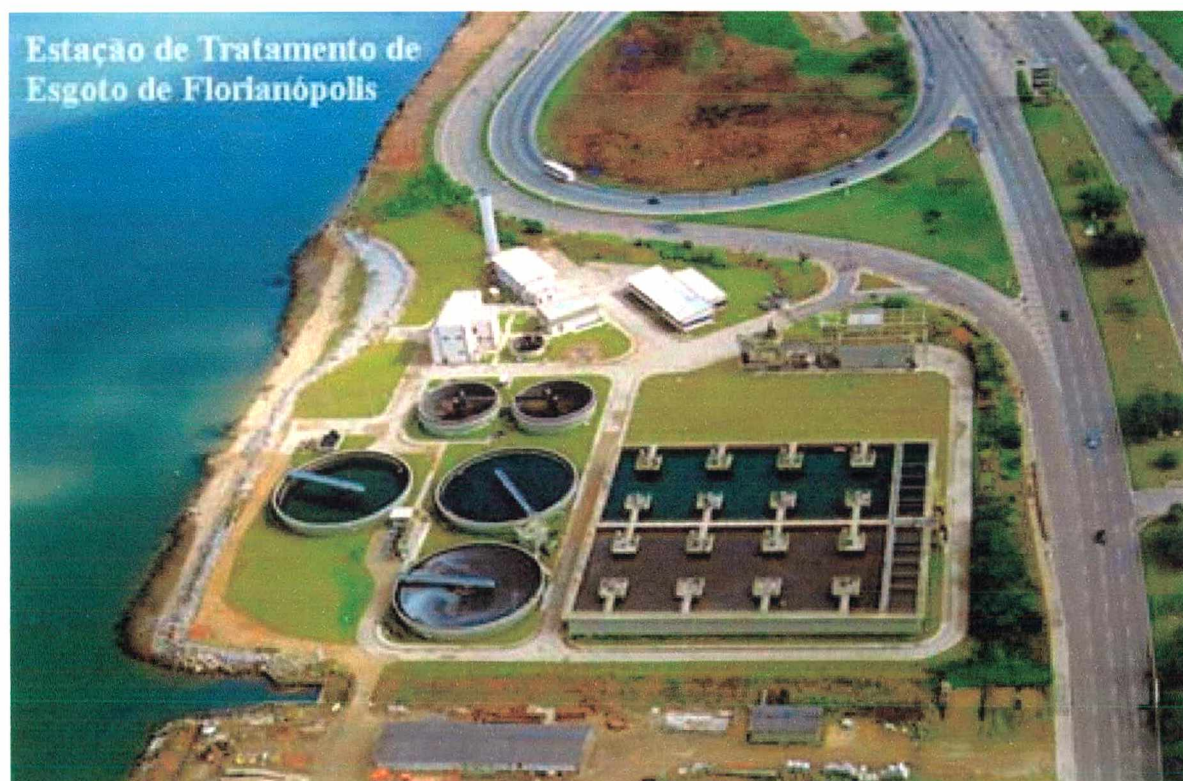
Figura 09 – Vista aérea do Sistema Insular de Tratamento de Esgotos de Florianópolis/SC.
