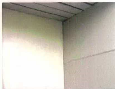
Exemplo de paredes com cores adequadas
