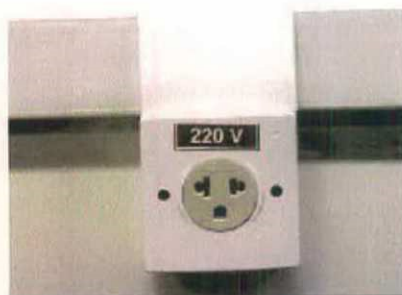
Tomada tripolar monofásica (3 pinos) padrão NEMA 5P
