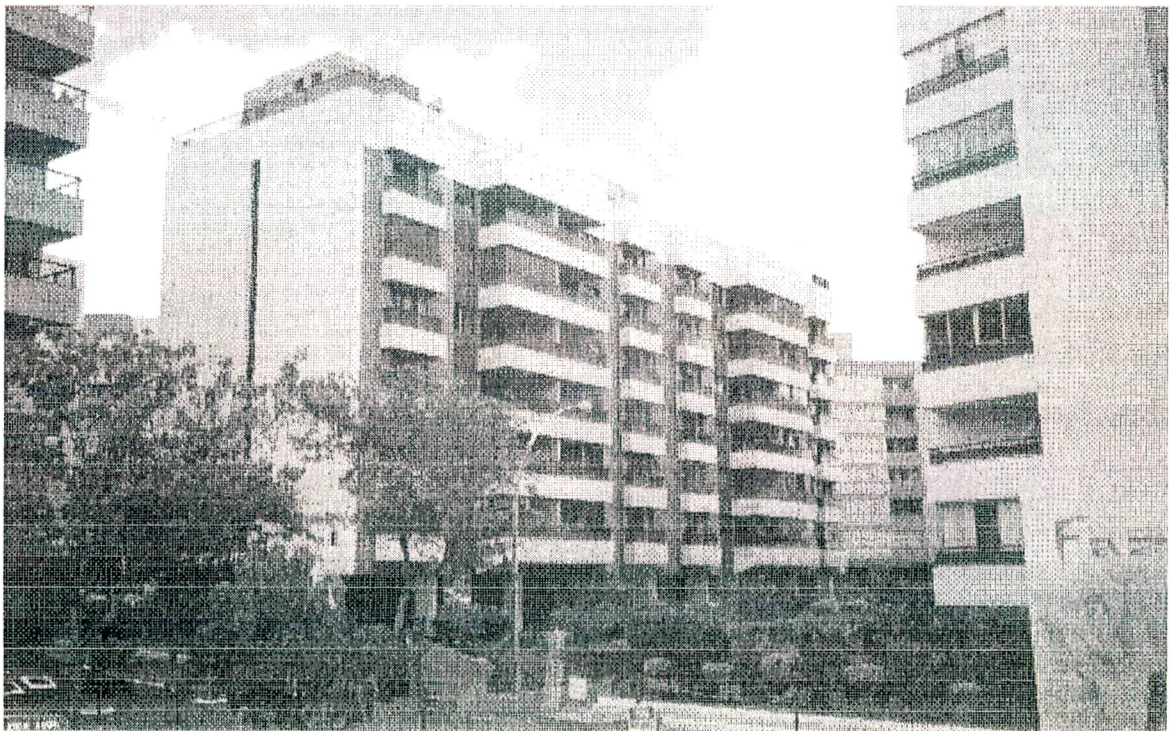
Figura E.4 - Fotografia do Edifício 043 (SsTr6TpCbCm, 4Qsdv2g-24, UMS 40,28 / m 2 )
