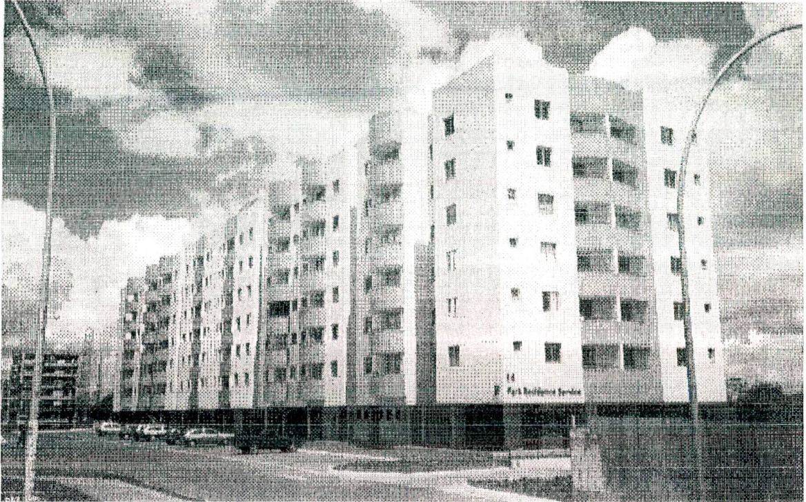
Figura E.3 - Fotografia do Edifício 042 (SsTr6TpCm, 2/3Qsvg-120, UMS 35,98 / m 2 )
