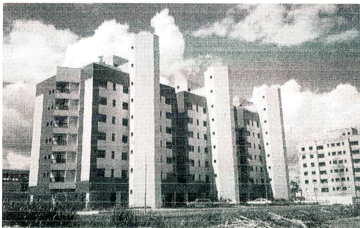
Figura E.12 - Fotografia do Edifício 056 (SsTr6TpCbCm, 4Qsdv2g-36, UMS 37,23 / m 2 )
