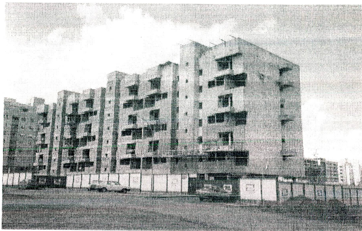
Figura E.15 - Fotografia do Edifício 074 (SsTr6TpCm, 5Q5sd2v4g-18, UMS 36,56 / m 2 )
