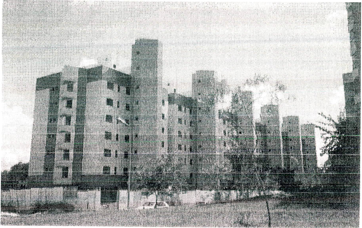
Figura E.13 - Fotografia do Edifício 065 (SsTr6TpCbCm, 4Q2sdv2g-72, UMS 38,93 / m 2 )
