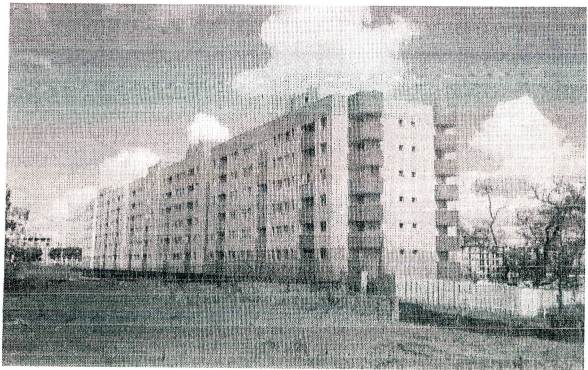
Figura E.14 - Fotografia do Edifício 066 (SsTr6TpCbCm, 2Qsv/3Qsdvg-132, UMS 30,52 / m 2 )
