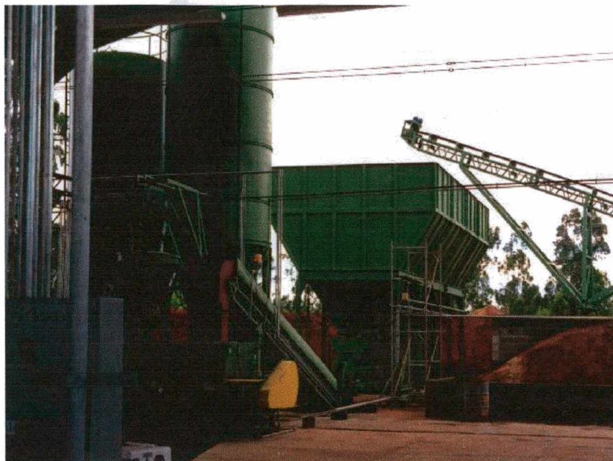
Figura 5: Fábrica de blocos de concreto. Detalhe dos silos de cimento e silo/balança de agregados
