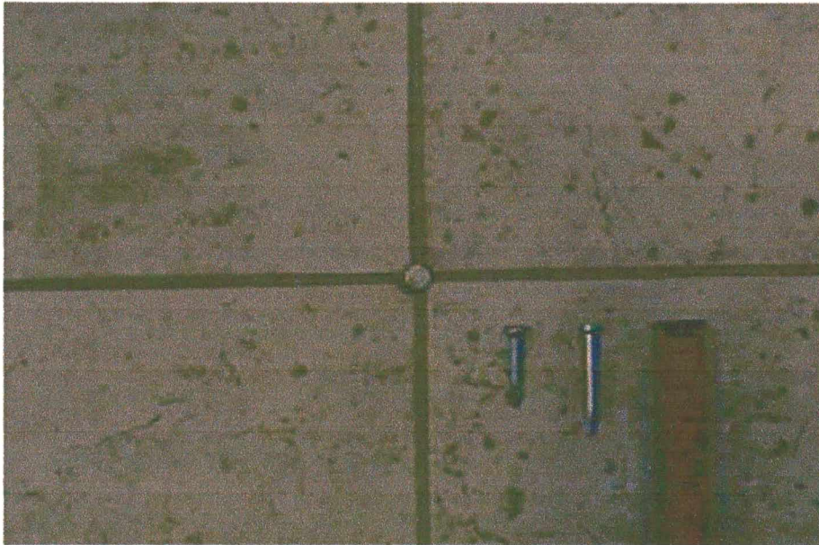
FIGURA 12 – Materialização dos vértices e pontos no interior do edifício (prego de aço).
