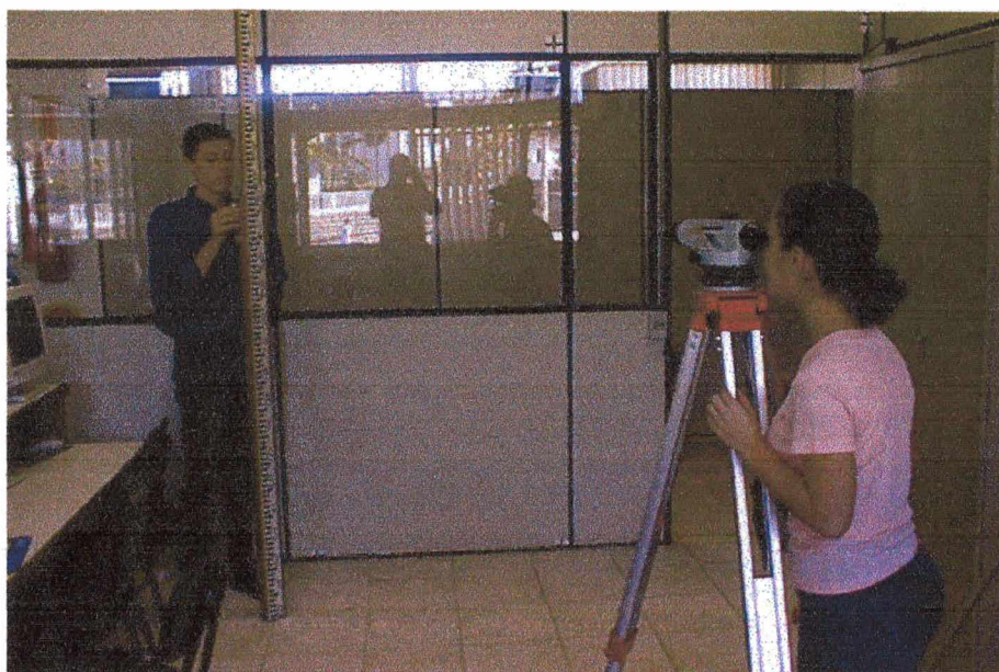
FIGURA 16 – Nivelamento geométrico no interior do edifício.
