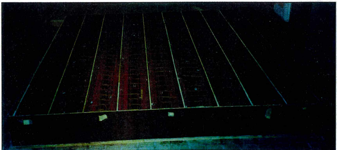
Figura 5.5 - Armadura convencional das vigas
