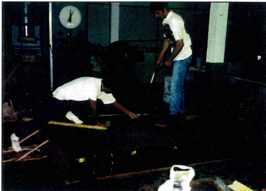
Figura 5.3 - Concretagem das vigas
