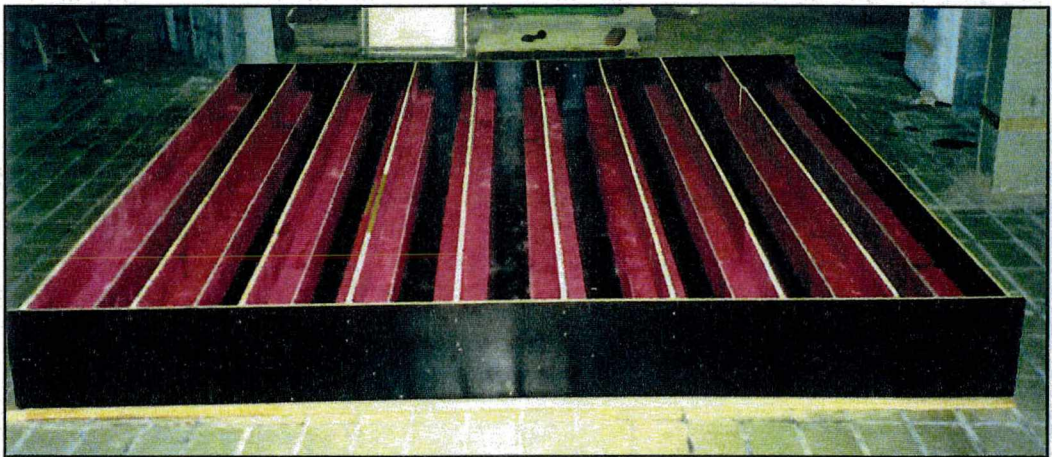
Figura 5.9 - Vista superior das fôrmas das vigas
