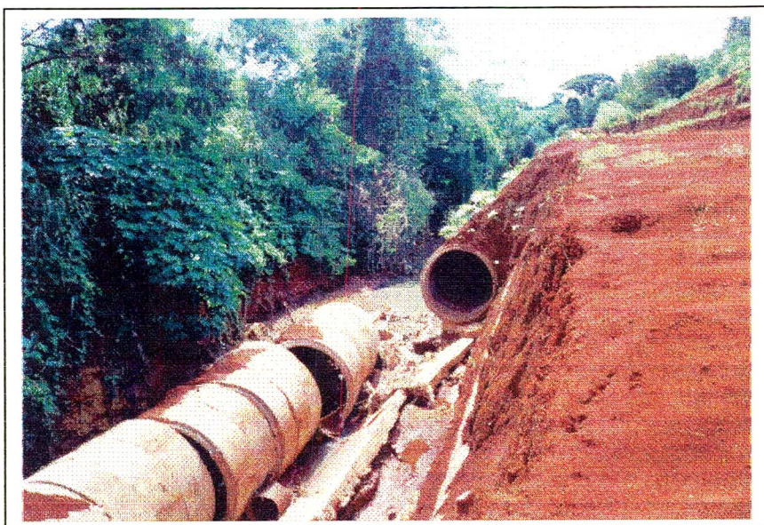
Vista parcial da canalização do Córrego Moscados. Data: Fev/98. Foto da autora.
