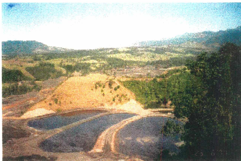
Foto 9 - Bacias de sedimentação de finos da Usina de Beneficiamento Boa Vista, quando ainda estava em operação, no ano de 1994.
