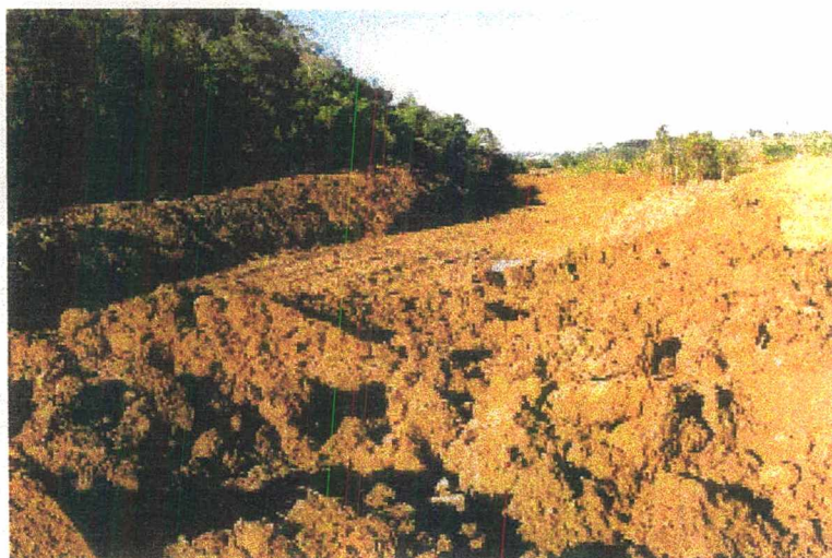
Foto 8 - Local previsto para a instalação das bacias de sedimentação de finos da Usina de Beneficiamento 3G. Foto tirada em 1998.
