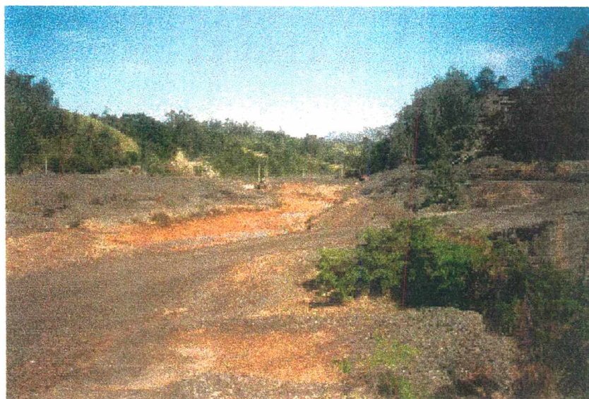
Foto 10 - Rejeitos usados como base para o leito de estradas.
