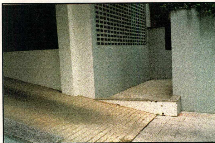
Figura 5.26 - Vão próximo à rampa de acesso à garagem
