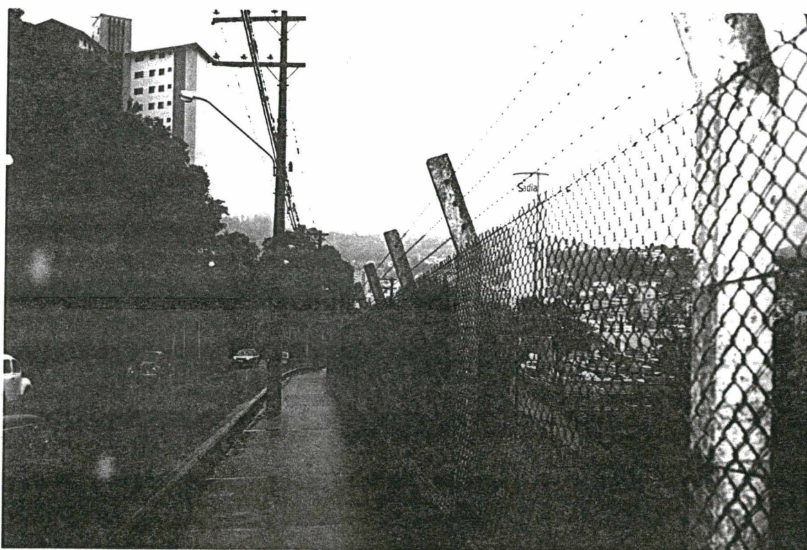
Figura 21. Proximidade dos condensadores (ao lados dos quais está o depósito de amônia) à via pública de acesso à cidade.
