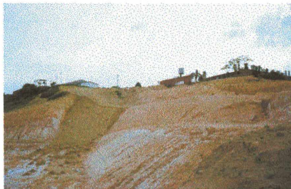
Foto 23 – Voçoroca Creche 1 depois da obra de contenção. Manaus – AM. Dezembro/1997. (Foto do autor).
