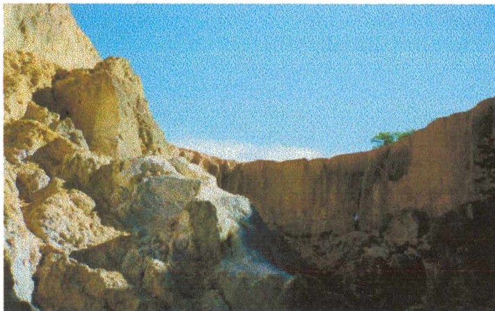
Foto 12 - Voçoroca Siderama 3. Manaus – AM. Abril/1997. (Foto do autor).
