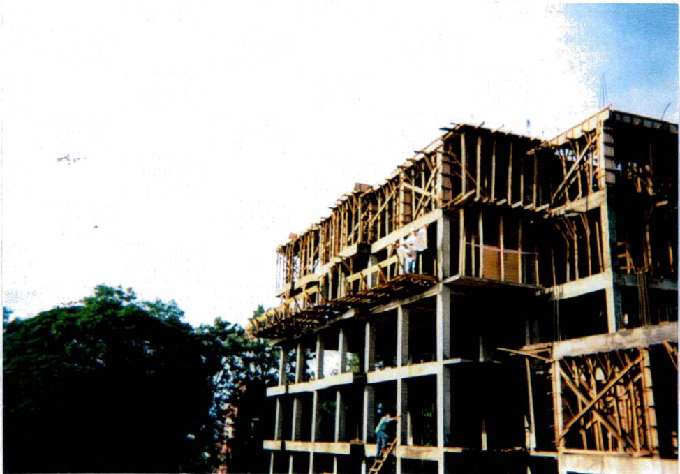
Figura 4.4 – Colocação da bandeja salva-vidas
