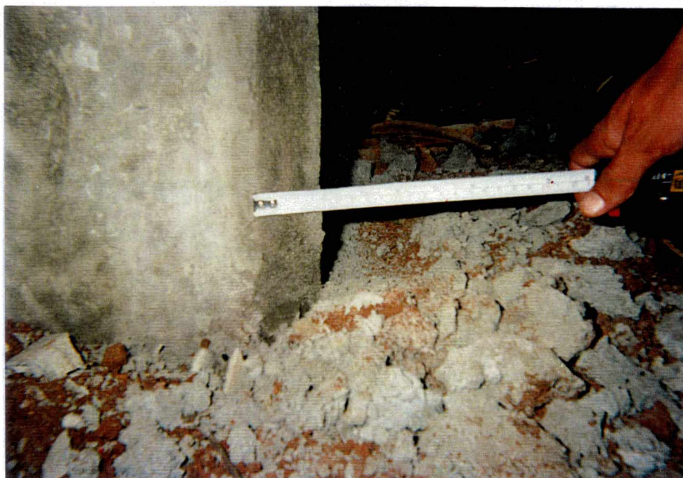
Figura 4.5 – Desaprumo de pilar provocando retrabalho
