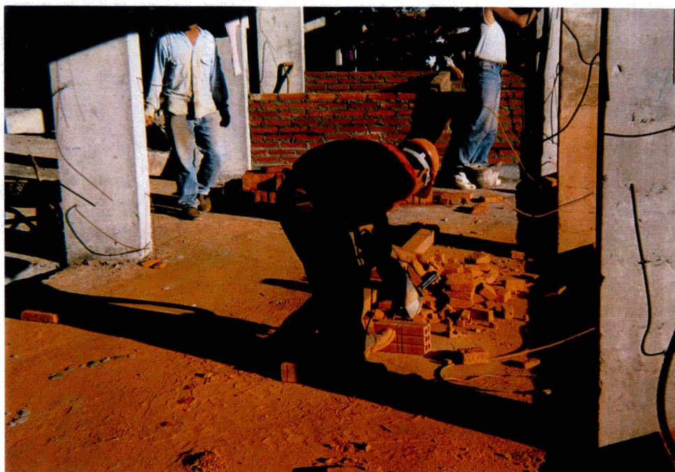
Figura 4.13 – Corte de meios tijolos.
