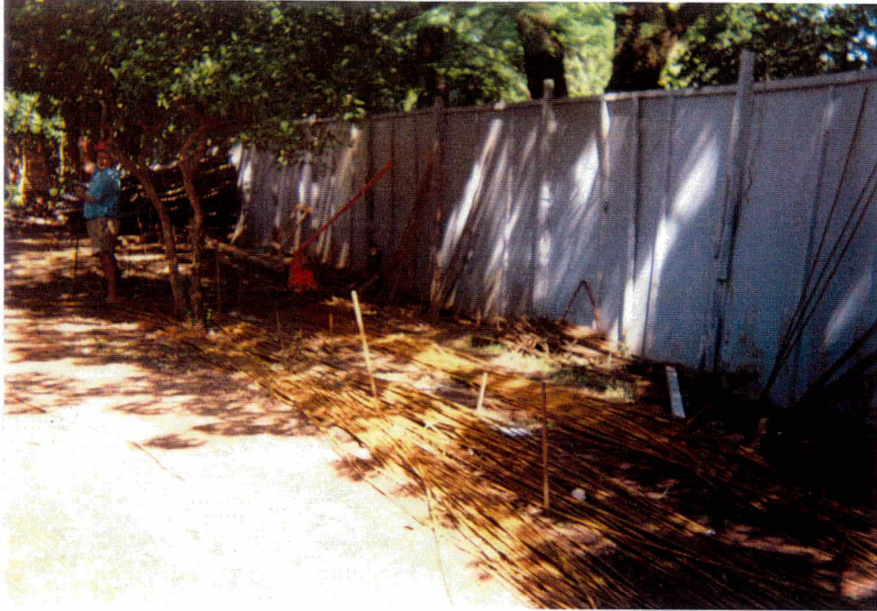
Figura 4.7 – Disposição do aço antes da intervenção
