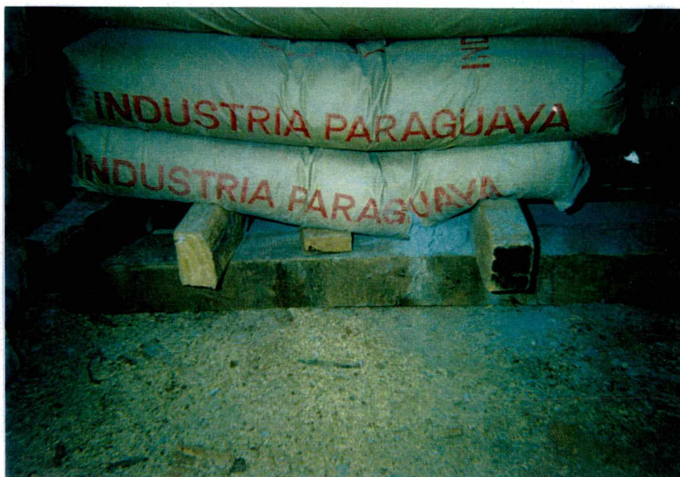
Figura 4.6 – Desperdício de cimento devido às más condições de armazenamento
