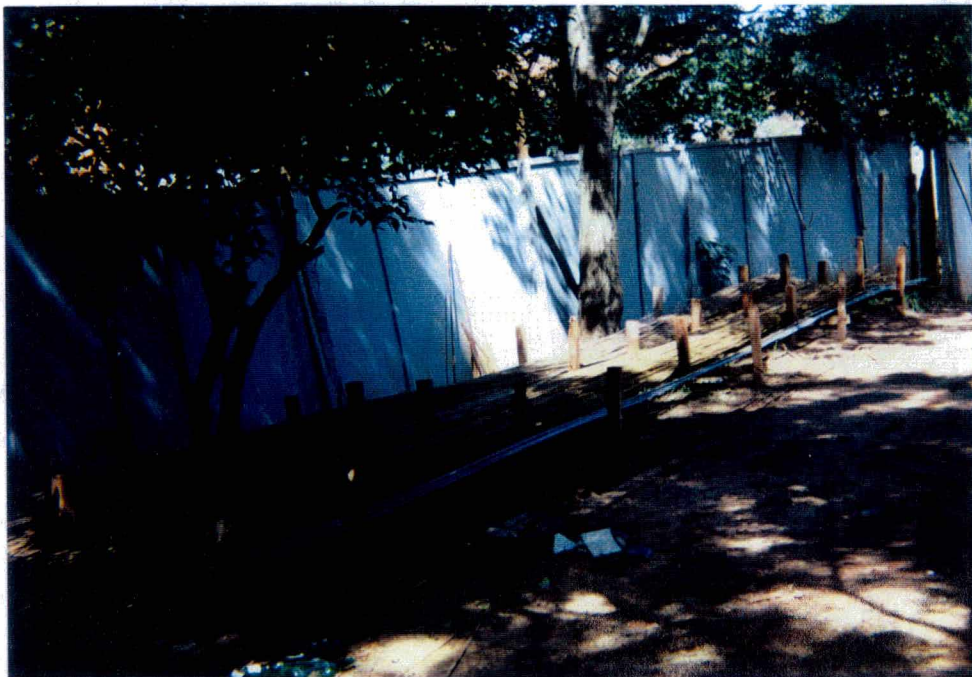
Figura 4.8 – Disposição do aço após a intervenção
