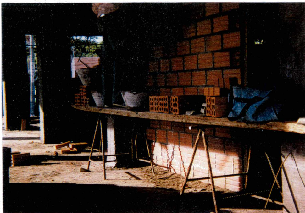
Figura 4.14 – Cavaletes metálicos realizados com os retalhos das armaduras de vigas
