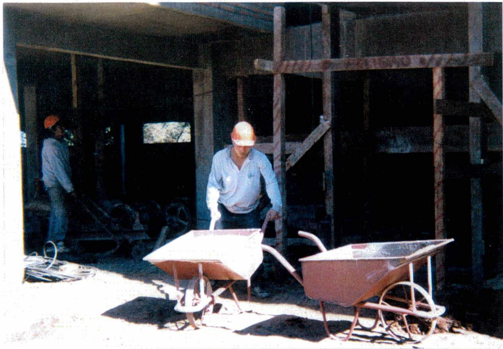
Figura 4.10 – Carrinhos redimensionados para o transporte de argamassa
