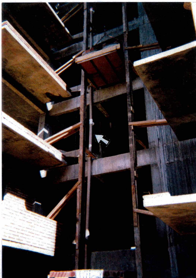
Figura 4.12 – Instalação do tubofone para melhorar o sistema de comunicação
