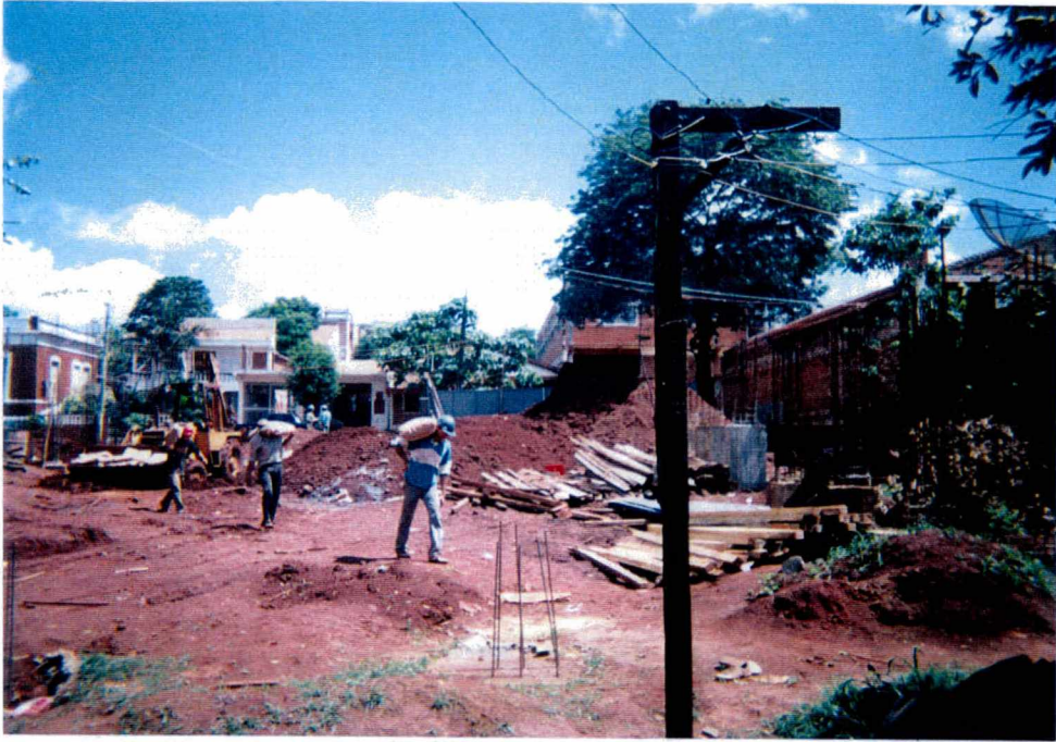
Figura 4.3 – Transporte de materiais pelos operários devido ao caminhão não poder ingressar até o depósito.
