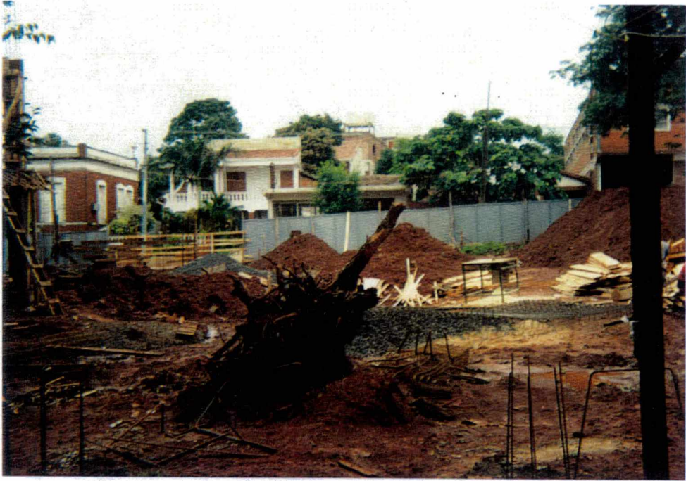
Figura 4.1 – Canteiro de obra antes da intervenção
