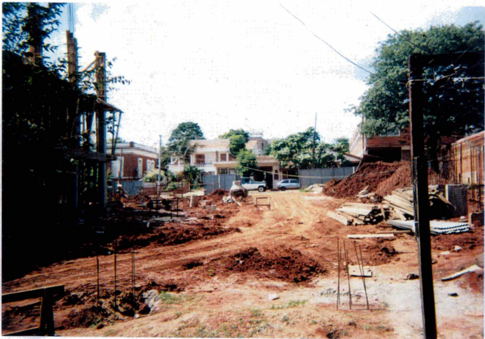
Figura 4.2 – Canteiro de obra após a intervenção
