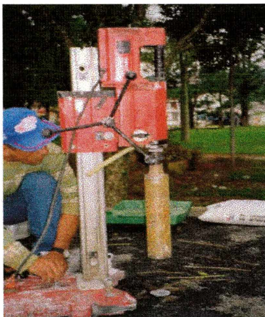
Figura 3.10 – Equipamento utilizado para extração de testemunhos de concreto.
