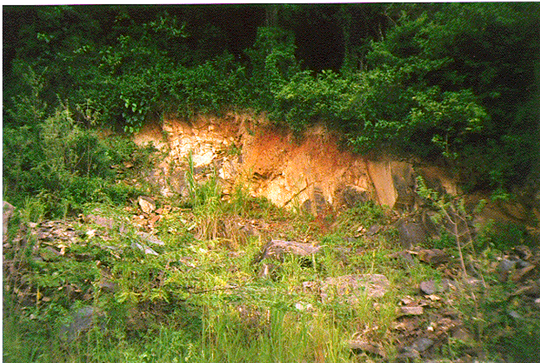
Foto 6: Pequena pedreira de Diabásio, localizada atrás da encosta onde houve o escorregamento. Pouca espessura de solo e fraturamento intenso do diabásio.
