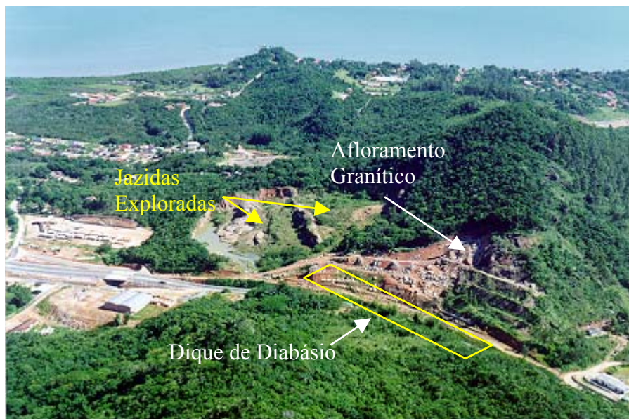
Foto 3 – Vista aérea do corte do Morro do Cacupé, já após os serviços de terraplenagem pós-escorregamento. Ainda podem ser verificadas as três banquetas existentes e a cunha de deslizamento, que passou preferencialmente pela vertente direita da encosta.
