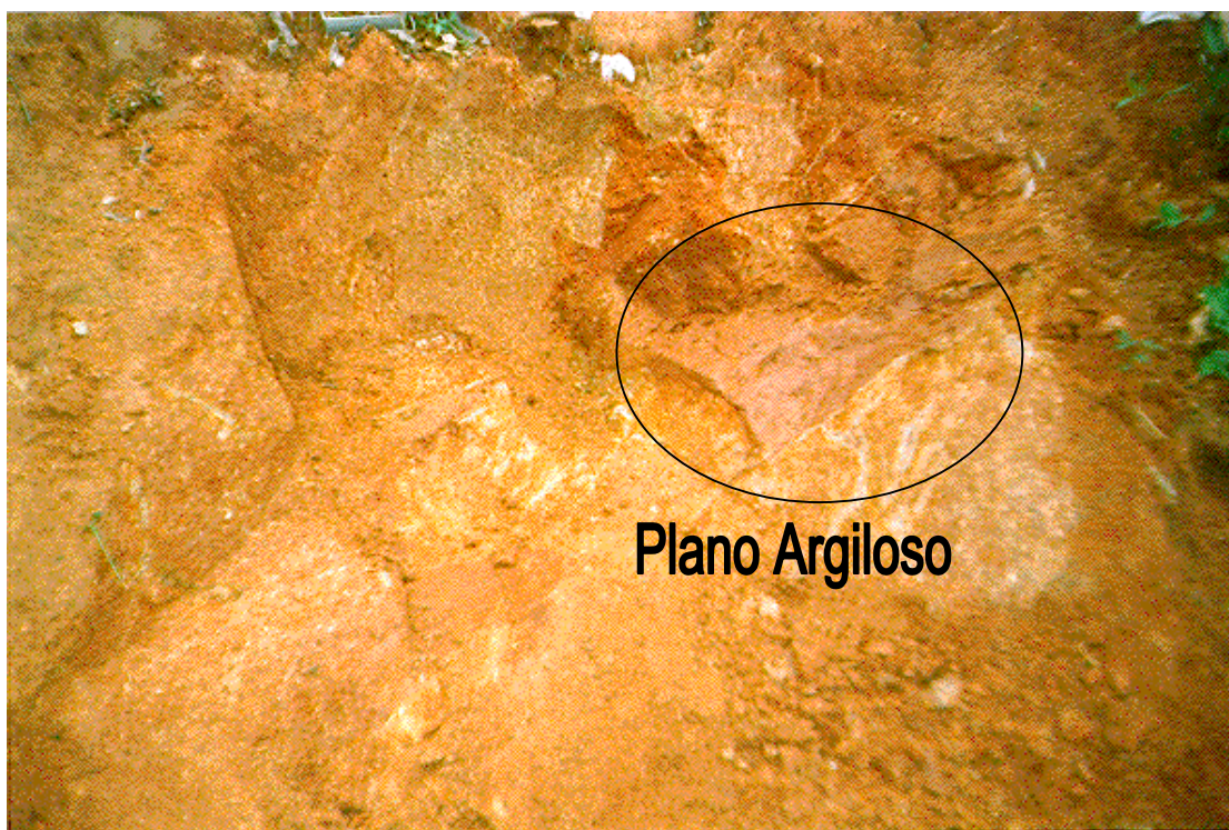
Foto 4: Planos argilosos no interior do horizonte C. Solo altamente plástico, caracterizado pela presença de óxido de ferro, com orientações diversas. A orientação predominante está no sentido paralelo a do escorregamento. Nota-se manchas esverdeadas a cinza em todo o horizonte C, caracterizando os planos de fraqueza da rocha de origem.
