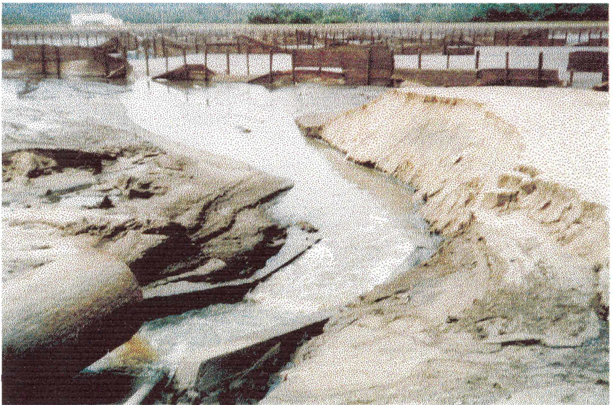
FIGURA 12 - Formação "ilhas" de areia na região de entrada do esgoto bruto na lagoa anaeróbia 2
