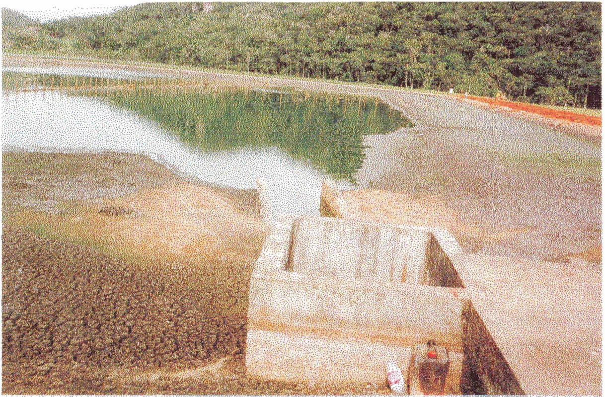
FIGURA 14 - Presença de berna ao longo de toda extensão da lagoa facultativa 2
