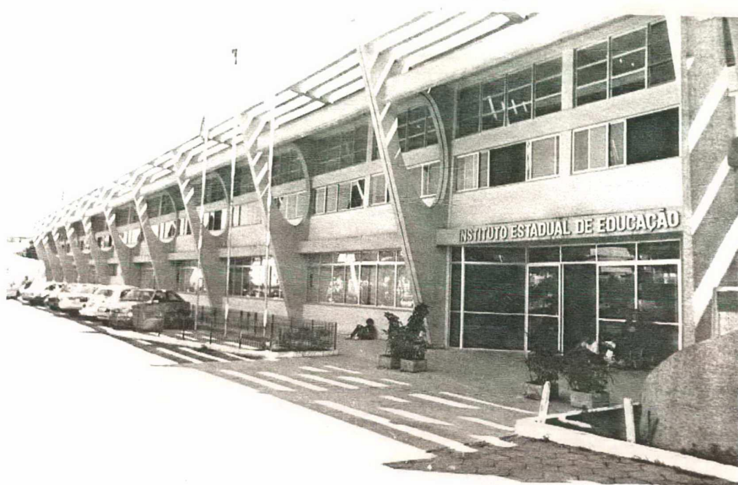
Fig. nº 20. Fachada frontal do Instituto Estadual de Educação, em Florianópolis, onde se pode notar os elementos de proteção solar.
