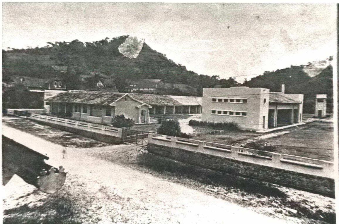
Fig. nº 12. G. E. Rui Barbosa. Construído em 1938. Joinville.
