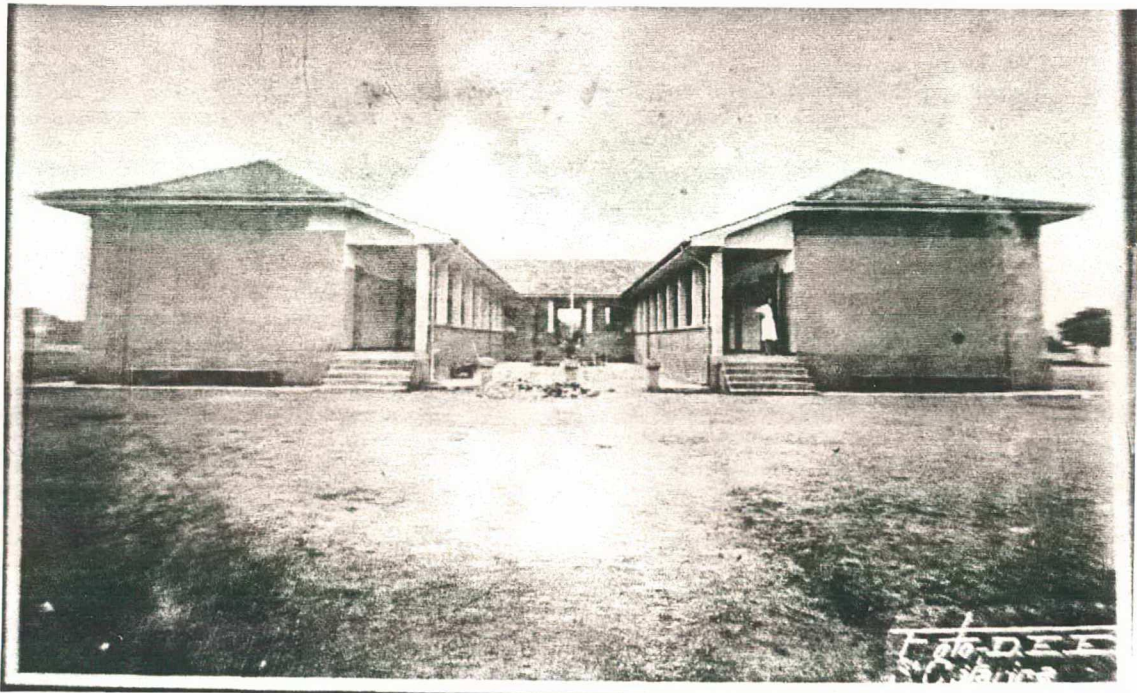
Fig.nº 8. Pátio interno do G.E Almirante Barroso. Canoinhas. Construído em 1939.
