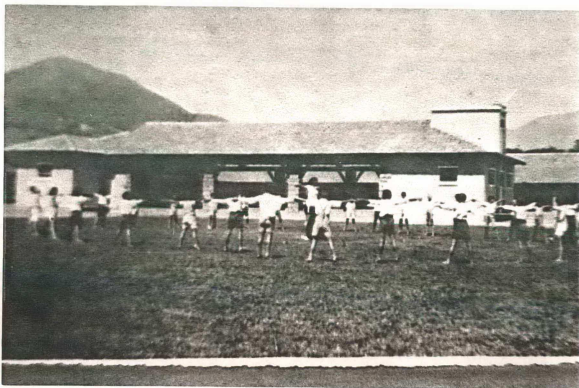
Fig. nº 18. Pátio de educação física, no G.E. Nereu Ramos, Palhoça, construído em 1941.
