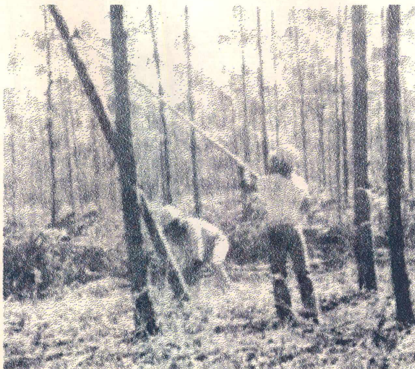
Figura 3.6 - Derrubada com motosserra e direcionamento da queda.
