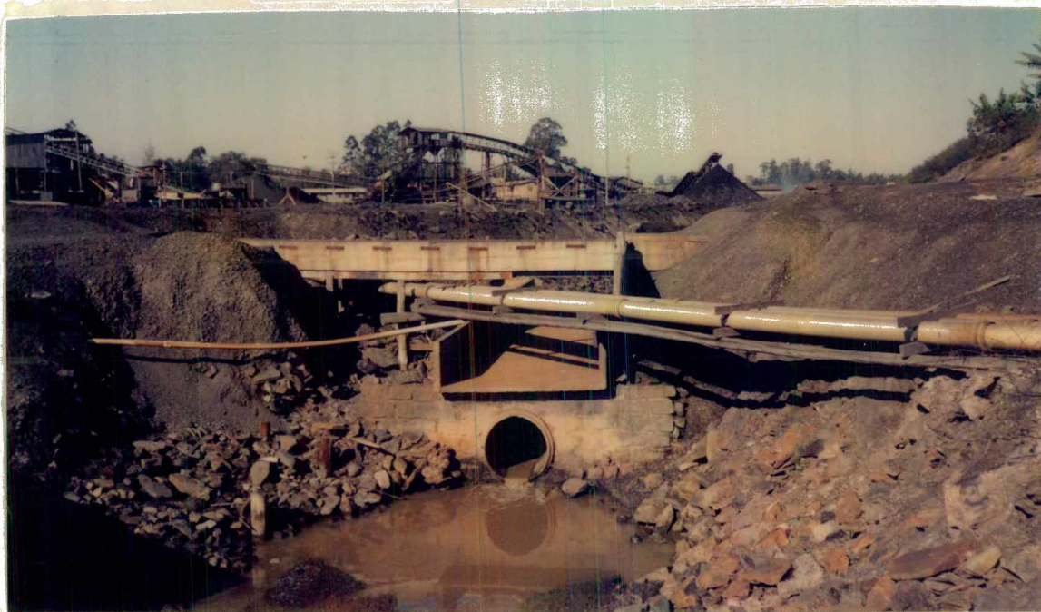
FIGURA 5.6 - Vista Parcial das Instalações da Mina da Companhia Carbonífera Urussanga - Lançamento de efluentes líquidos na área provenientes da lavação do carvão mineral.
