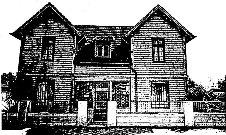
Foto V.29 - Sobrado da Família Ritzmann, em Canoinhas. Feito pelo sistema "balão", com esquadrias de ferro e de madeira. Vista frontal.
