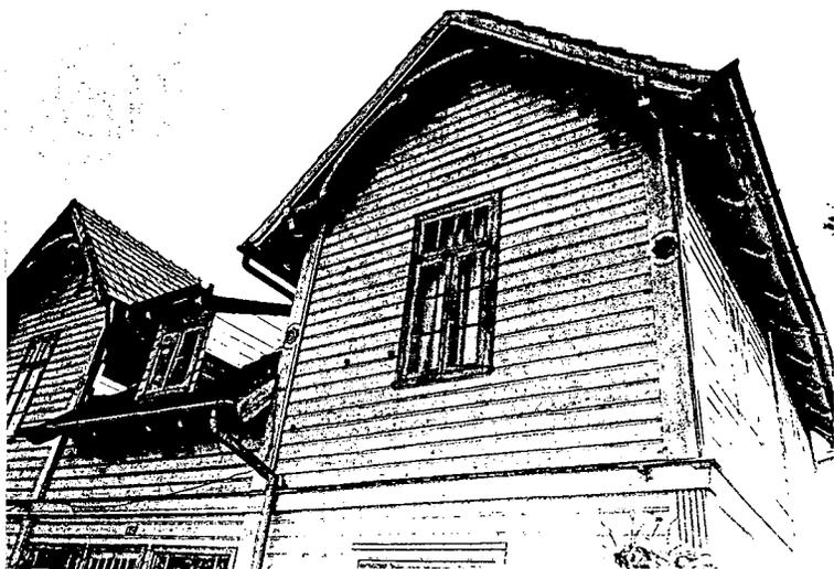
Foto V.31 - Sobrado da Família Ritzmann, em Canoinhas. Detalhe dos beirais com cachorros.
