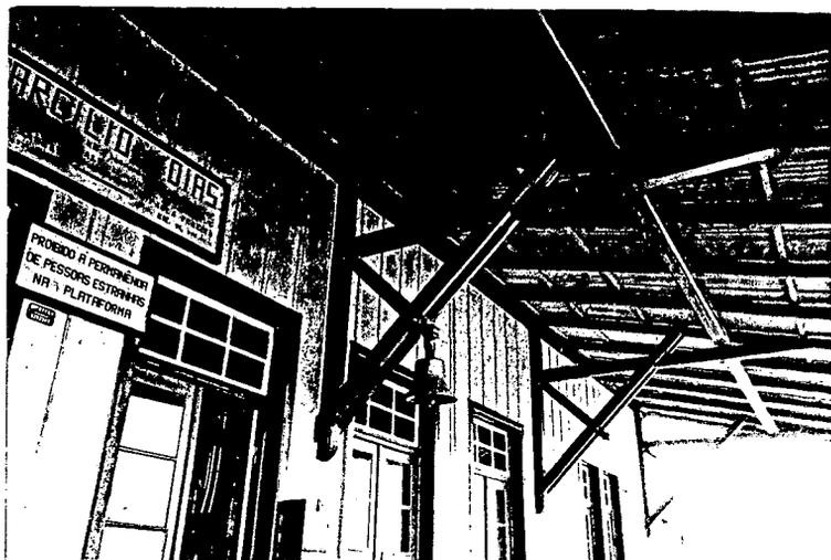
Foto I.12 - Estação de Marcílio Dias. Vista inferior da plataforma coberta. Feita com tábuas verticais e mata-juntas.
