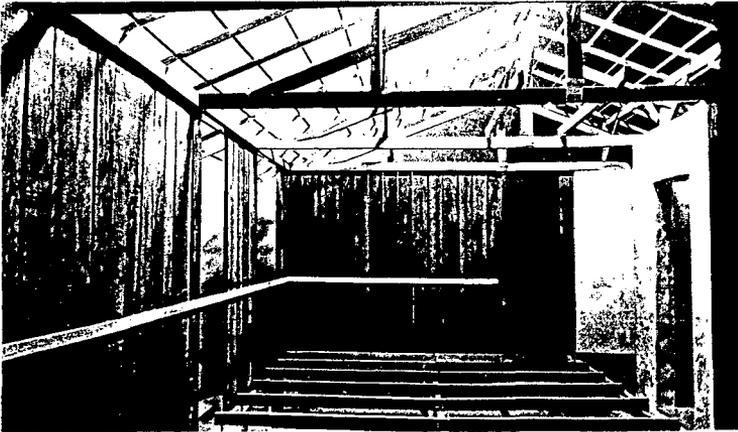
Foto V.78 - Travamento intermediário interno colocado nas tábuas de fechamento.
