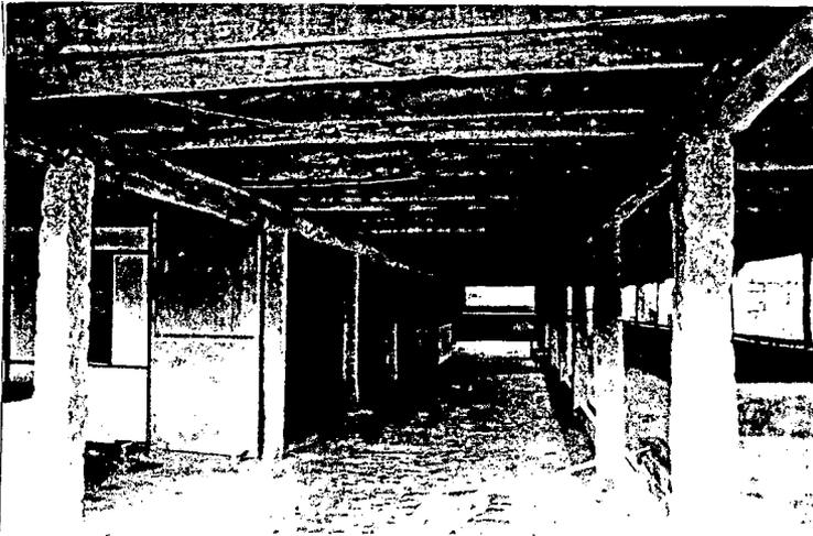
Foto V.20 - Museu ao Ar Livre. Madeiramento do piso apoiado nos monolitos.
