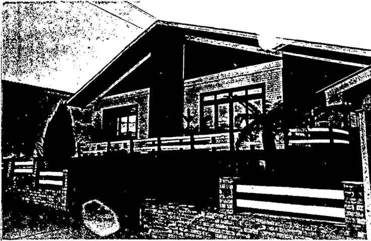
Foto VII.13 - Casa na R. Emilio Ribeiro, em Bom Jardim da Serra. Combinação de painéis duplos de madeira com alvenaria de tijolos aparentes.
