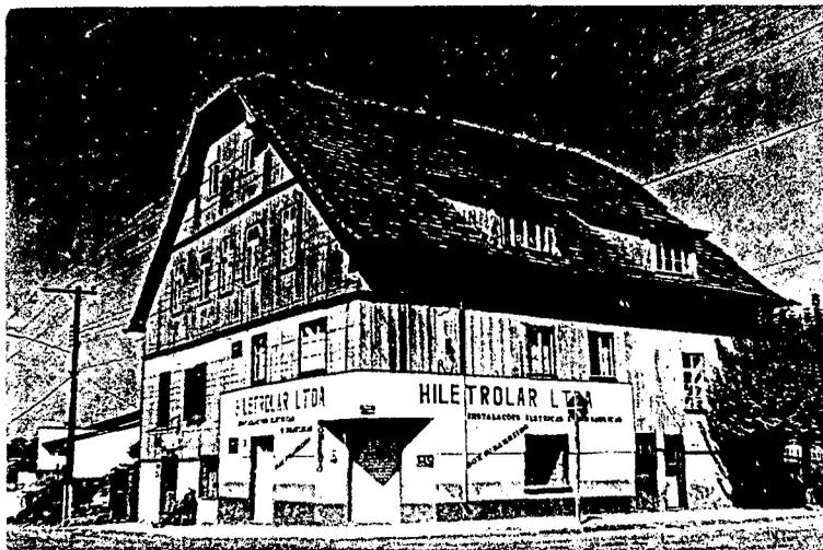
Foto I.15 - Antigo hotel em Canoinhas com 3 pavimentos em madeira, construído no início do século.
