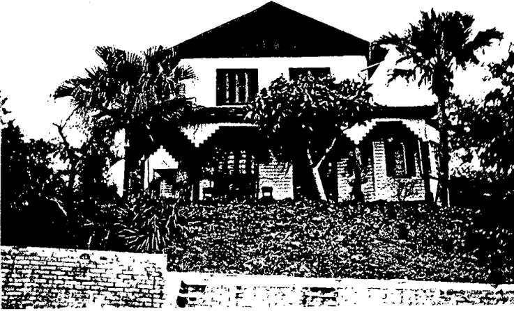
Foto V.22 - Casa na R. Fernando Machado 695, em Chapecó. Feita no sistema "balão". Detalhe da varanda e do frontão.
