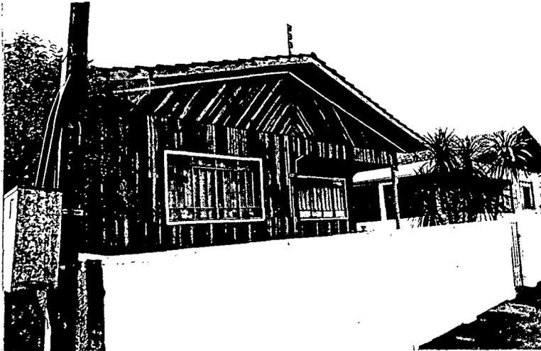
Foto VII.4 - Casa pré-fabricada de painéis
